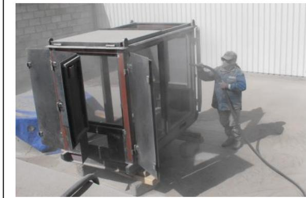
*a) Inicio de aplicación del arenado a la parte exterior de la estructura y a las puertas abatibles.*
