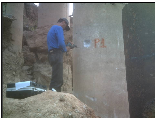
Figura 10. Elaboración de nichos y perforaciones para colocación de sensores
