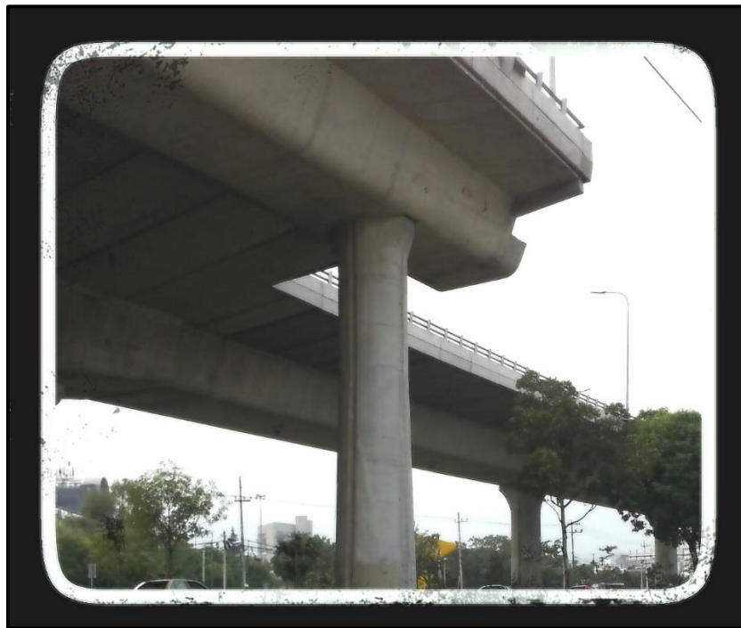
Figura 3.3 Columna oblonga viii en Anillo Periférico
