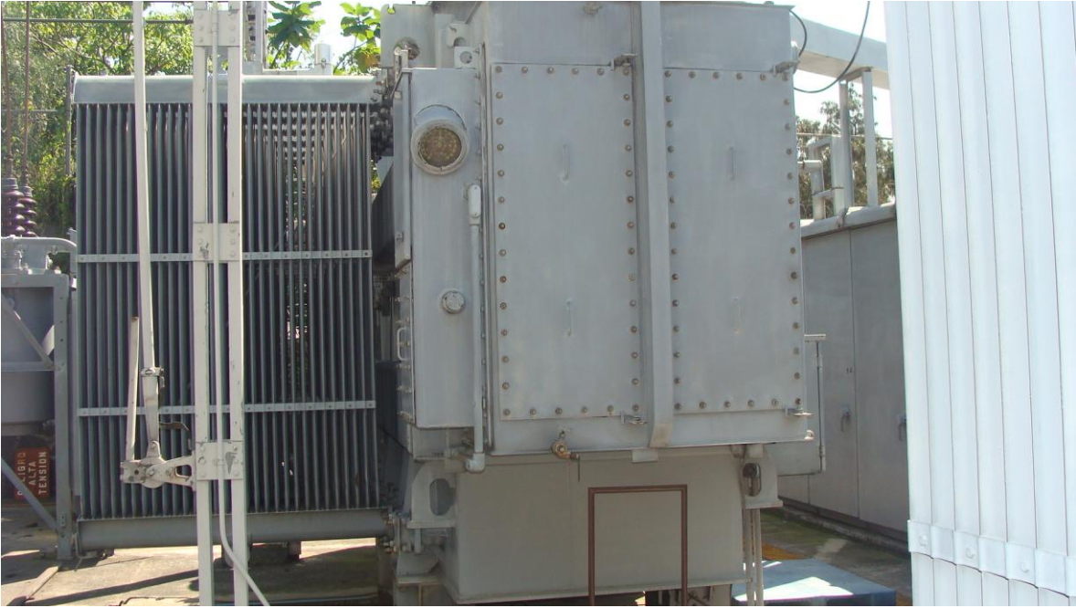
Cambiador de derivaciones (Fig. 1.5)
