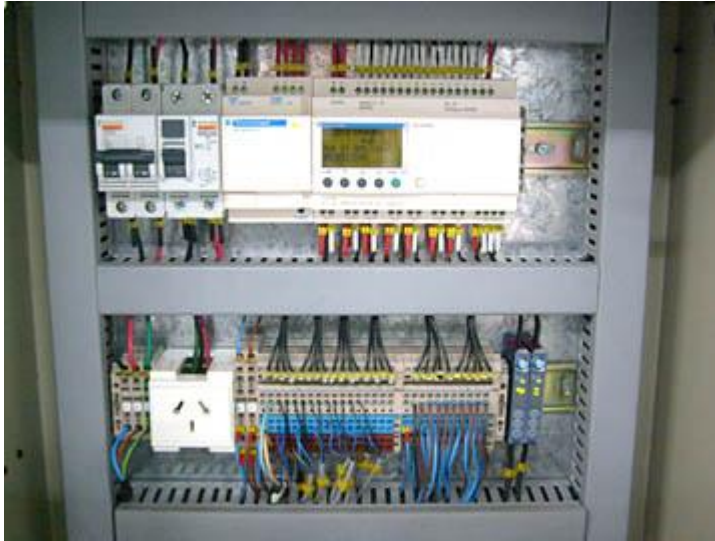
PLC instalado en tablero de control
