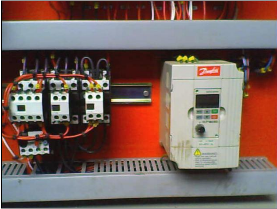
Arrancador con auxiliares de protección.
