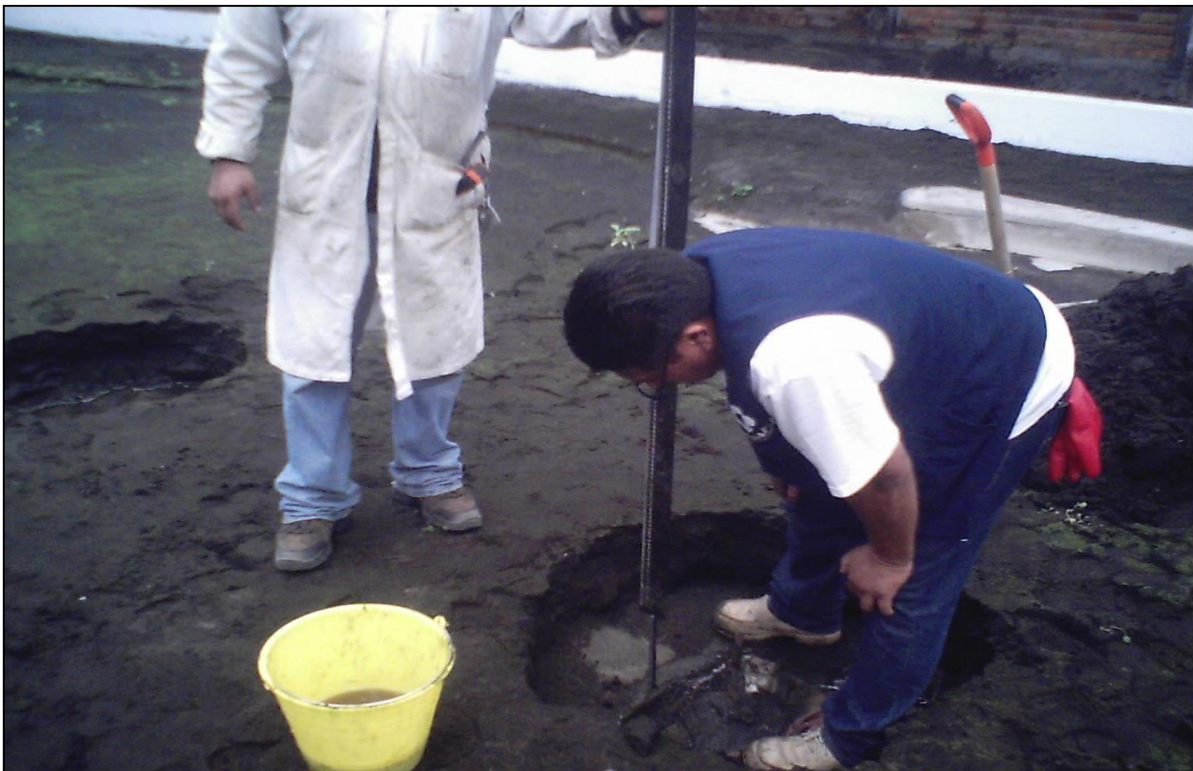
Figura 3.2b Colocación de regla en el punto A
