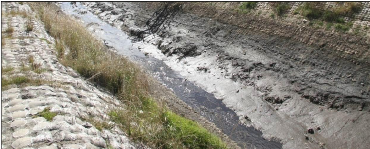
Figura 4.4 Ejemplo de un tramo de canal cubierto con el tapete flexible
