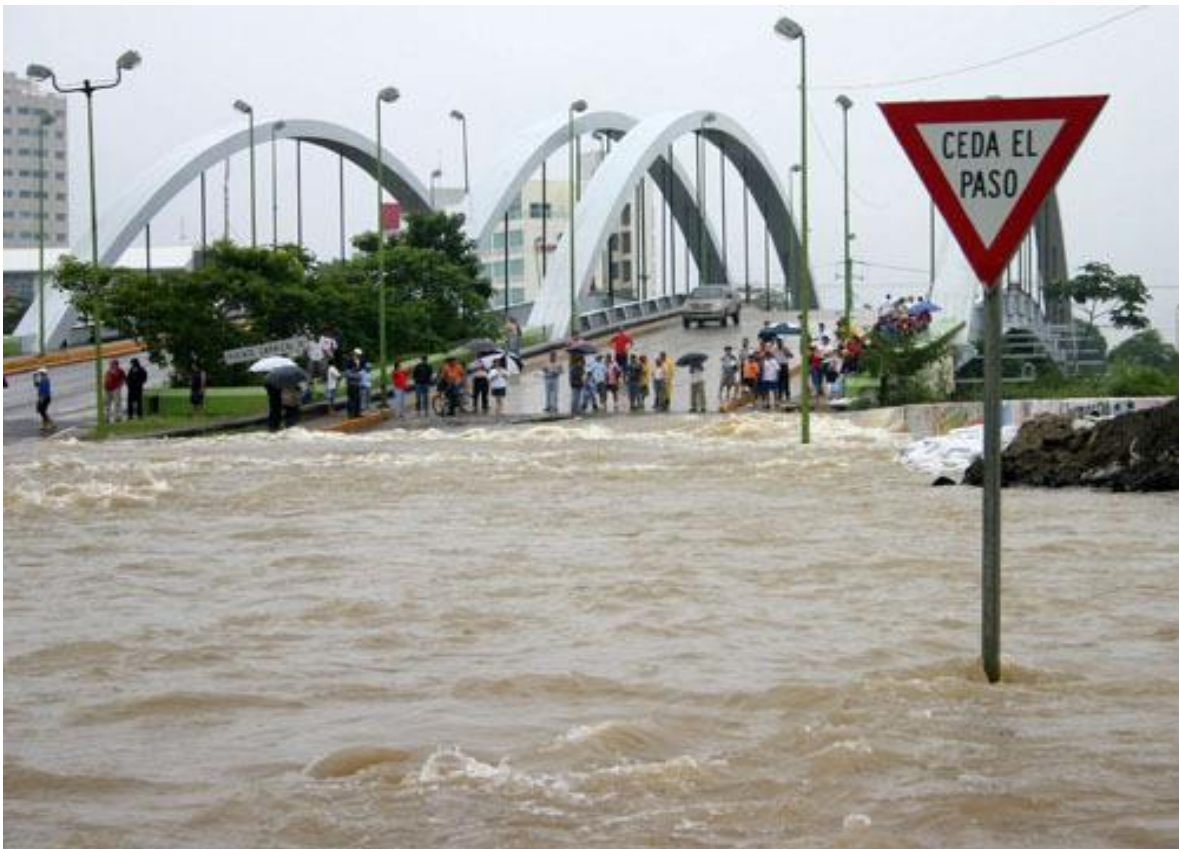
Figura I. Zona inundada de la Ciudad de Villahermosa
