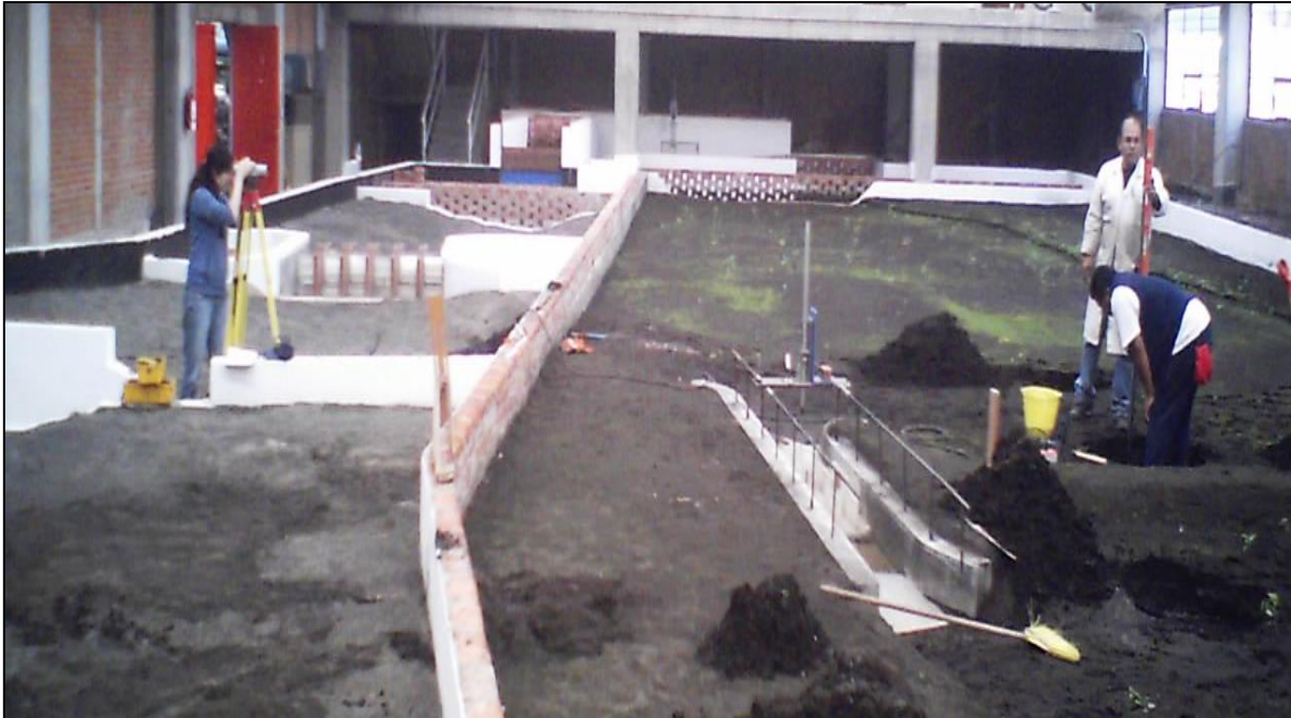
Figura 3.2a Nivelación del sitio de medición, punto de medición A
