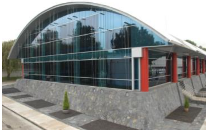
Figura 1.5. Edificio de M-PDL
