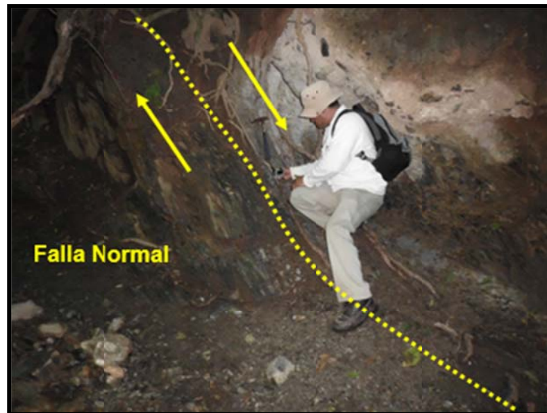
Fotografía 4.16. Se observa la traza del plano de falla de tipo normal, la estructura presenta 1,0 m de espesor de material triturado con alteración por argilización.
