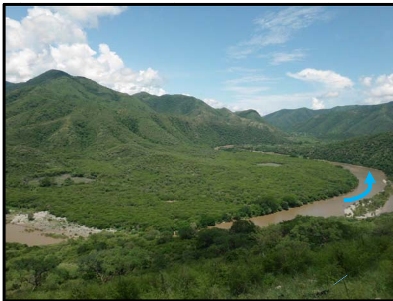
Fotografía 3.1. Panorámica del relieve topográfico de la margen izquierda de la zona de embalse. Nótese la grande extensión de los depósitos de Terraza aluvial.
