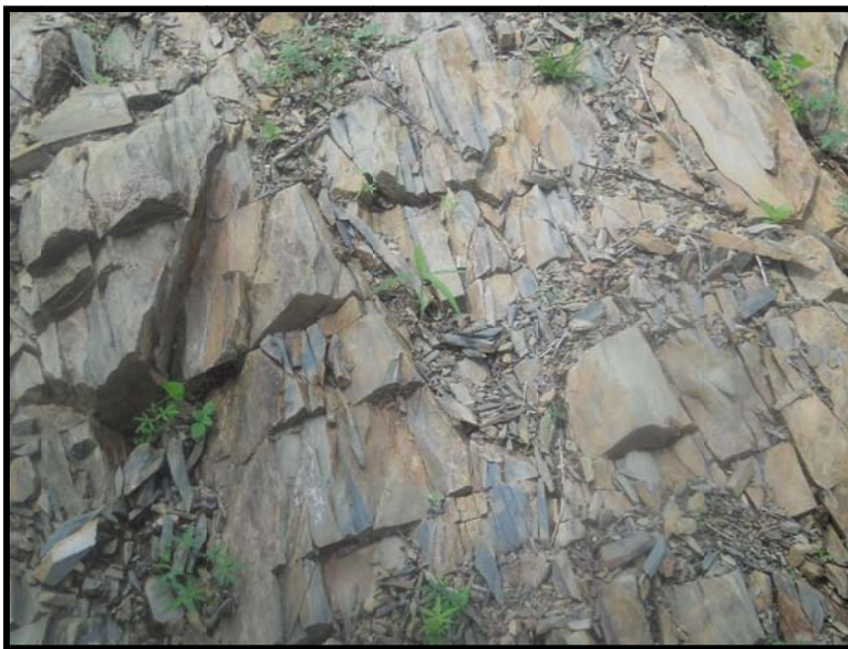
Fotografía 4.3. La metalutita en roca alterada es de color pardo amarillento y está muy fracturado, cuyo rompimiento es a través de los planos de la foliación.
