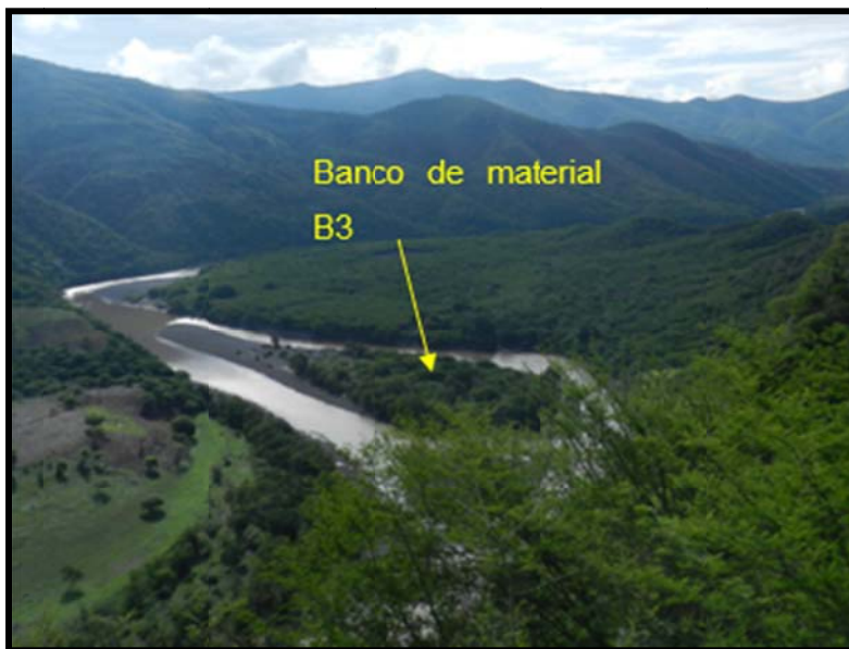
Fotografía 6.2. Islote localizado a 300,0 m aguas arriba del eje "GEOL". El banco está formado por una gran acumulación de materiales de acarreo (gravas, arenas y algunos bloques) subredondeados.
