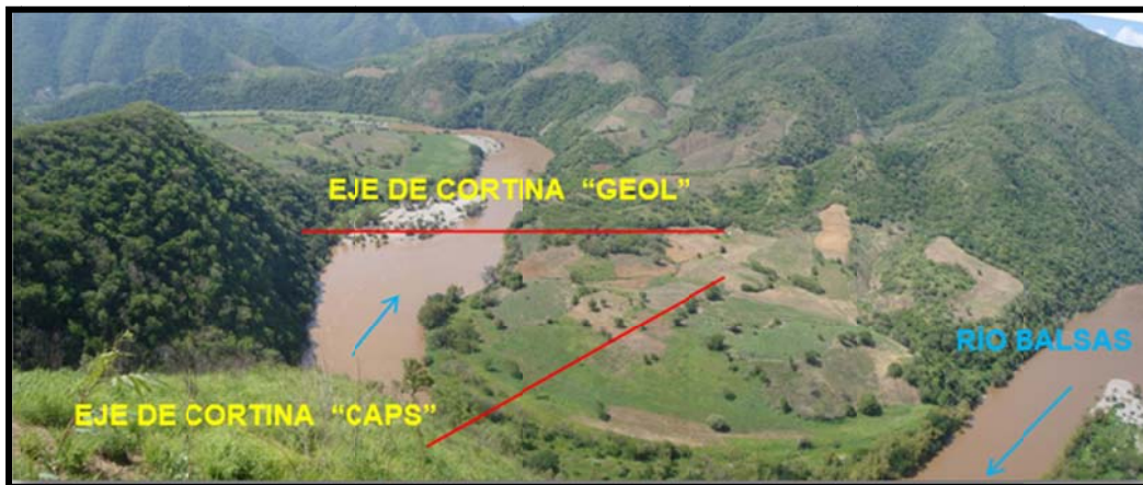
Fotografía 4.1. Se muestra la localización de los ejes de cortina considerados para el proyecto PH El Pescado y las condiciones topográficas y geomorfológicas del sitio.
