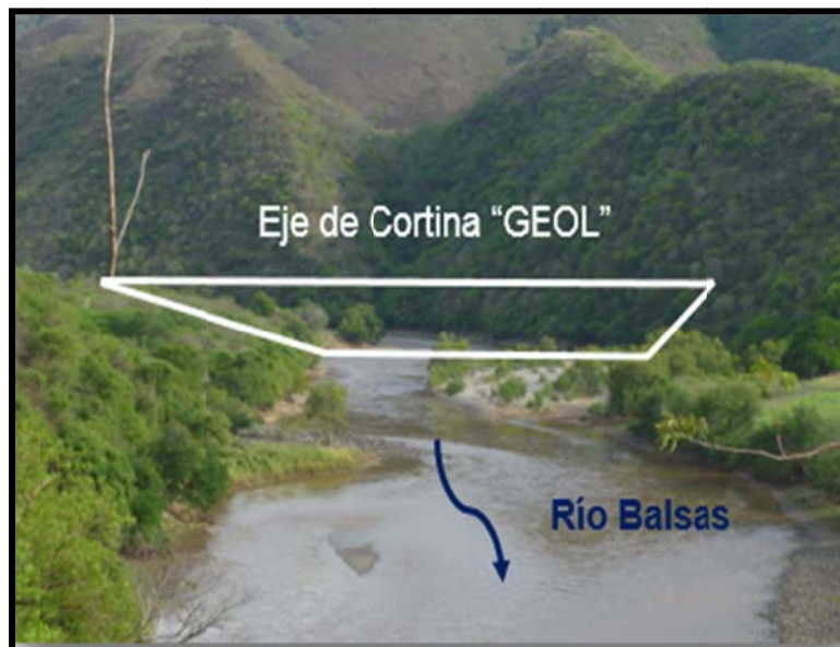
Fotografía 5.1. Trazo del eje de cortina “GEOL” cuya orientación es E-W; sección 3G-3G’.
