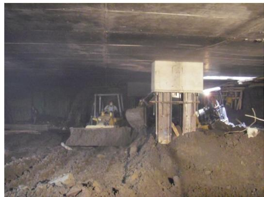
**Fig. 2.u.** Perfiles embebidos en concreto
