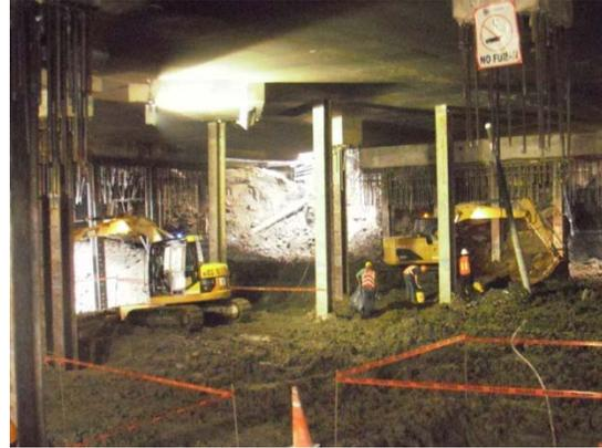
**Fig. 2.s.** Excavación con equipos minis
