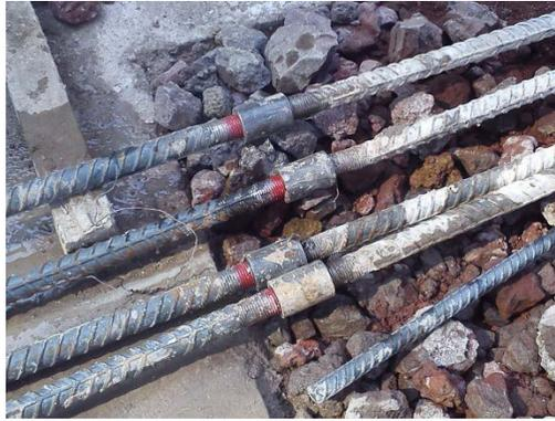
**Fig. 4.g.1. Conectores de varilla con roscado.**
