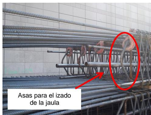
**Fig. 4.h.1. Elementos para izar el armado.**
