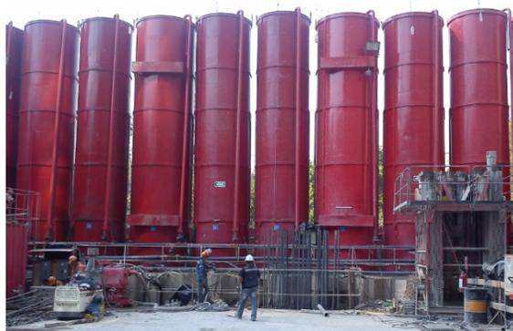
**Fig. 4.u. Silos para almacenamiento de lodo bentonítico.**
