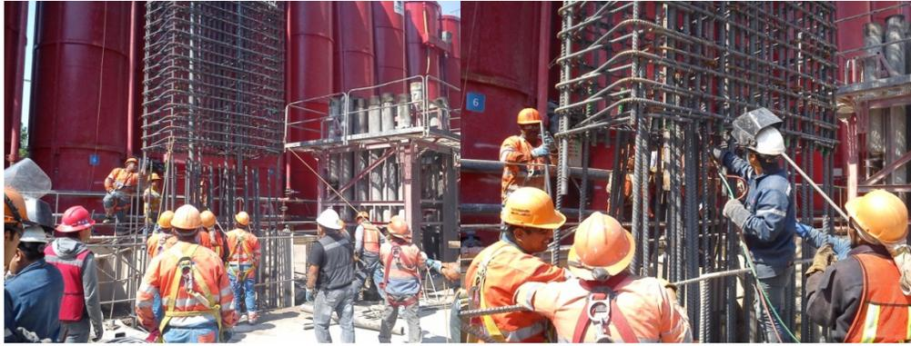
**Fig. 4.m.1. Descenso de una sección de la jaula y traslape de acero longitudinal mediante soldadura.**
