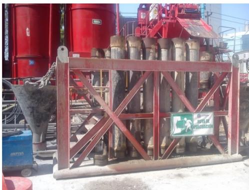
**Fig. 4.t.1. Tubería Tremie.**
