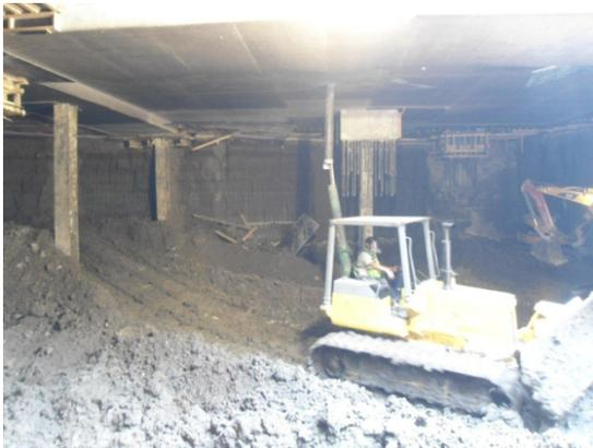
Fig. 2.p. Excavación bajo losas previamente coladas
