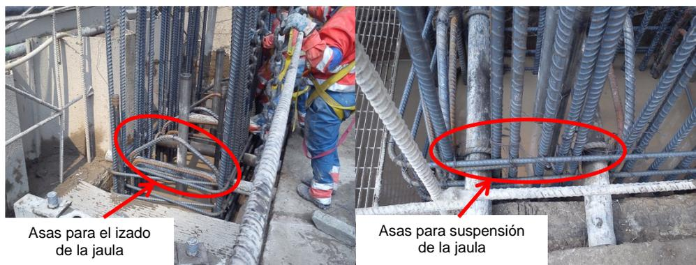
**Fig. 4.I.1. Asas para el izado y sostén del armado durante la unión de jaulas y colado.**
