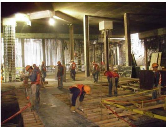
**Fig. 2.t.** Colocación de cimbra para una losa
