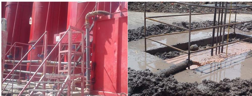
**Fig. 4.v. Sistema de tuberías para el transporte del lodo bentonítico.**
