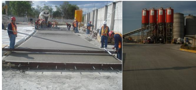
**b) Pavimento Planta de Concreto, Tuf-Strand SF:4.5 kg/m<sup>3</sup>**
