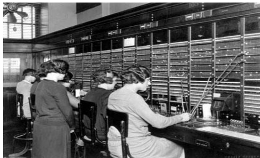
Figura 20 Operadoras en Central de comunicación
