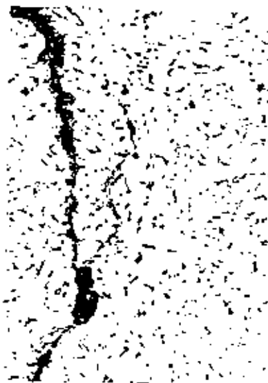
FIG. 203 x 55 Grieta en chapa de cobre
