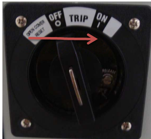
Figura 4. Se muestra la forma que tiene la perilla de encendido y la flecha indica hacia donde se tiene que girar.
