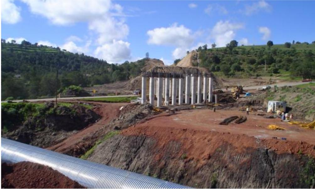
**Img 124.** Colocación de tubo de lámina para alcantarilla. Libramiento Norte de la Ciudad de México, km 103+983, hacia San Martín Texmelucan, DGDC-SCT.
