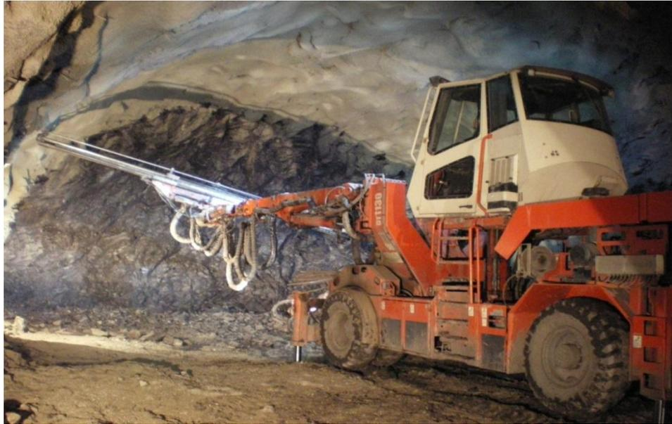
**Img 174.** Máquina barrenadora para la colocación de explosivos en túneles.
