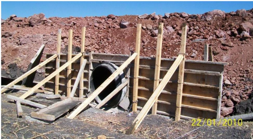
**Img 122.** Trabajos de construcción de alcantarilla de *tubo de concreto*. Libramiento Norte de la Ciudad de México, km 24+697.28, DGDC-SCT.
