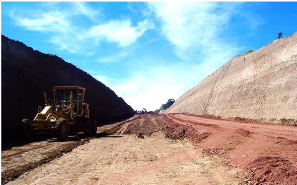
**Img 72.** Vista de corte, en donde se pueden observar dos taludes y la superficie a nivel subrasante. Libramiento Norte de la Ciudad de México, km 106+360 al km 106+740, DGDC-SCT.
