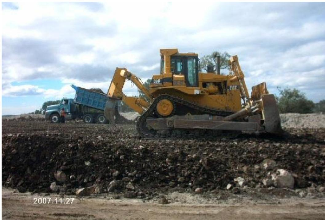
**Img 47.** Tractor sobre orugas tendiendo material para la conformación del cuerpo de terraplén. Libramiento Norte de la Ciudad de México, km 40+450, DGDC-SCT.
