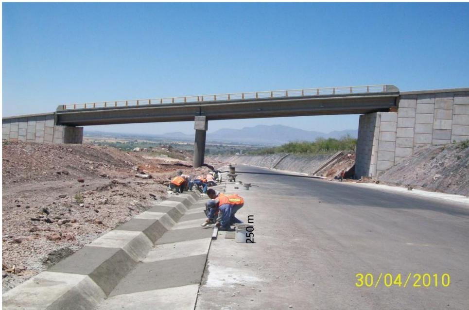
**Img 99.** Segundo colado alternado de losas y cierre del revestimiento de la *cuneta*.
