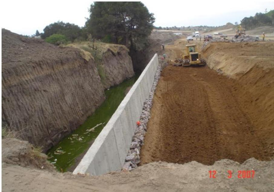
**Img 166.** Muro de contención adicional proyectado, debido a que el desplante del terraplén daba al centro del canal de aguas negras. Libramiento Norte de la Ciudad de México, DGDC-SCT.
