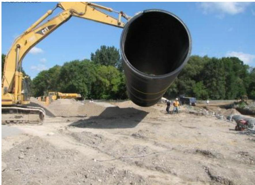
**Img 123.** Maniobras con *tubo de polietileno de alta densidad* para alcantarilla.
