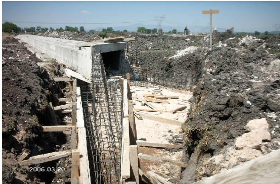
**Img 132.** Armado de aleros en obra de drenaje para su próximo cimbrado y colado.
