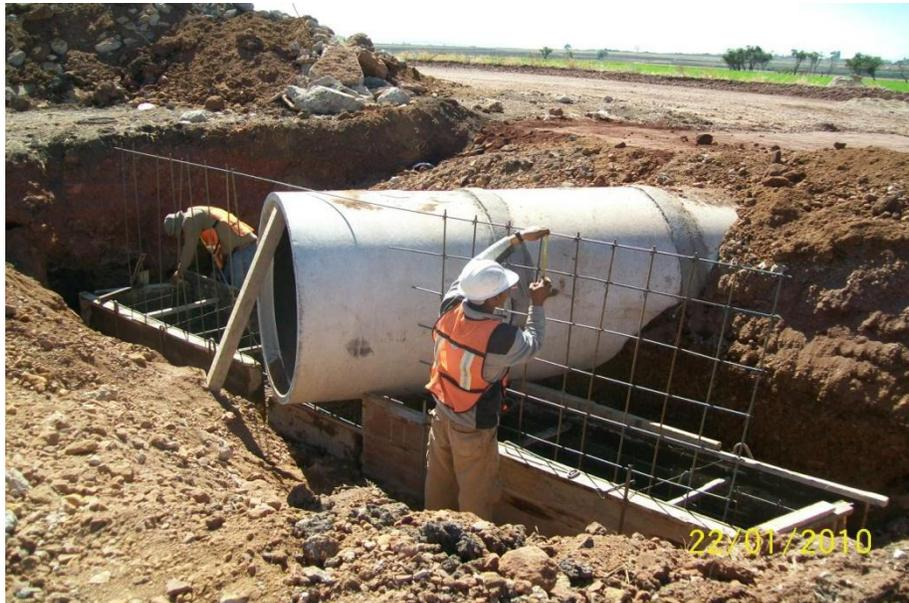
**Img 121.** Alcantarilla de *tubo de concreto*. Colocación del acero por temperatura en cabezotes. Libramiento Norte de la Ciudad de México, km 24+966.63, DGDC-SCT.
