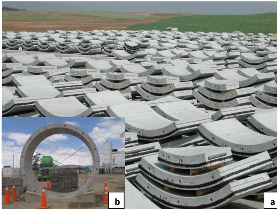
**Img 177a.** Dovelas que coloca el escudo para formar los anillos, y sirven como estructura de soporte del túnel.
