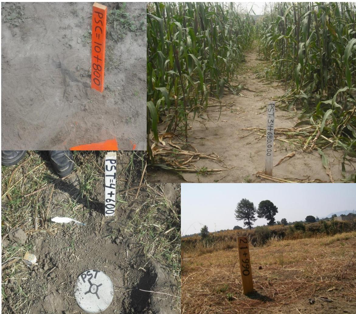
**Img 5.** En este conjunto de imágenes se pueden apreciar ejemplos de estacas colocadas para señalar el *trazo* del camino, fotografías: J. C. Mendoza Jiménez.
