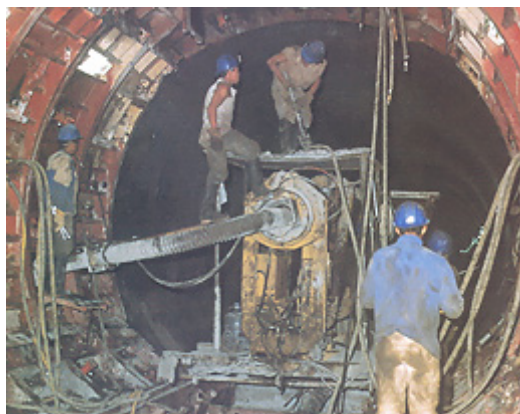
FIGURA 3.2.2. CONSTRUCCIÓN DE EMISORES DE DRENAJE.
