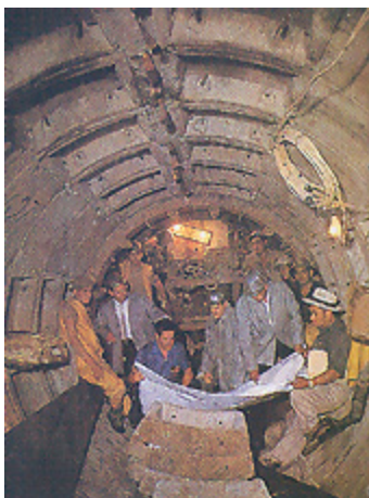
FIGURA 3.2.3. REVISIÓN DE ESTRUCTURAS DE DRENAJE
