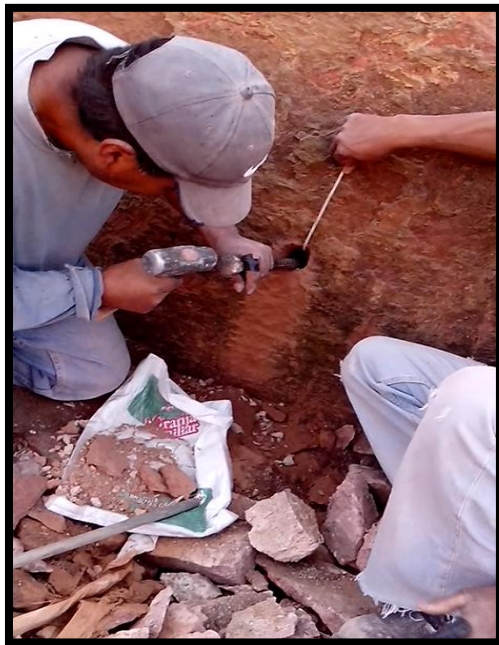
Figura 4. 5 Relleno con arena y grava del barreno.
