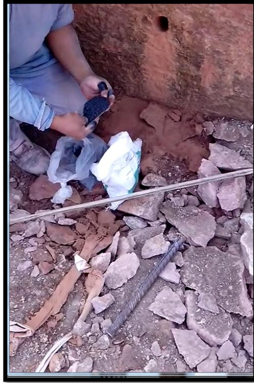
Figura 4. 3 Cargado del barreno con pólvora negra.
