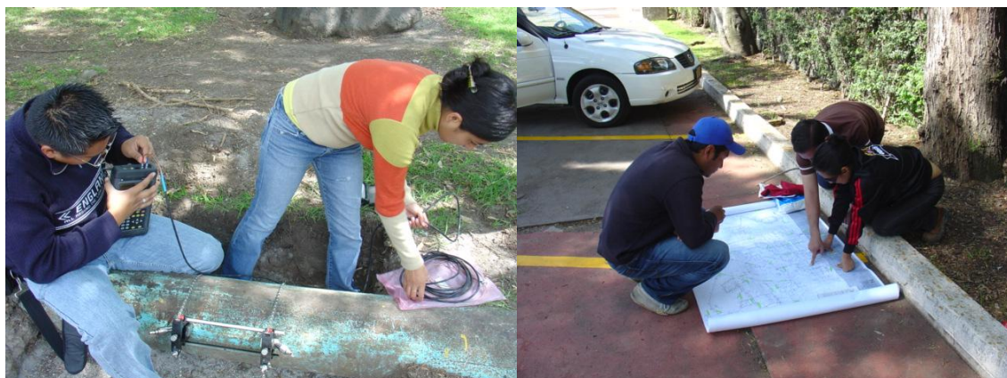
Figura 17. Trabajos de sectorización de la red de agua potable.
