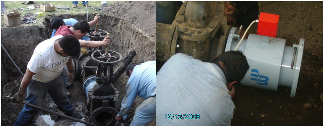
Figura 20. Instalación de Medidores Electromagnéticos.
