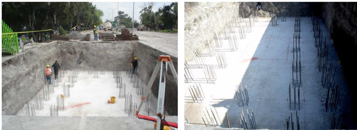
Trazo de ejes con equipo topográfico
