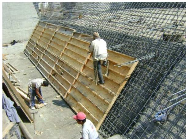
Armado estructural del muro de contención
