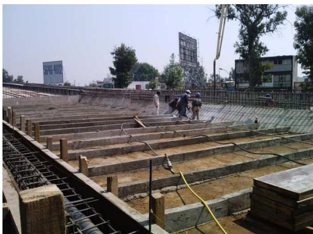
Rellenos y Tensores para liga de muros
