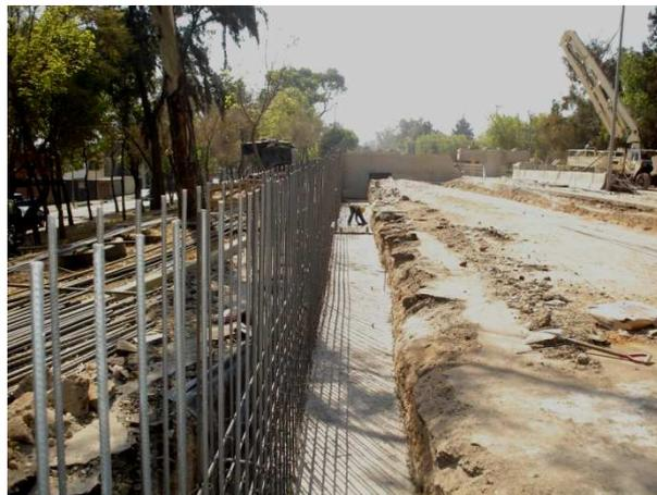
Corte del terreno para muro vertical
