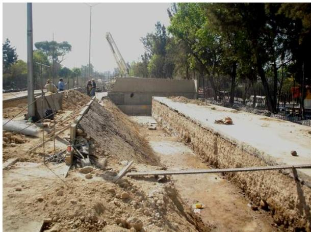
Corte del terreno para muro diagonal
