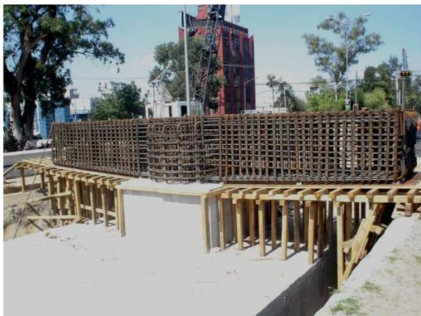
Fotografía del armado estructural del cabezal
