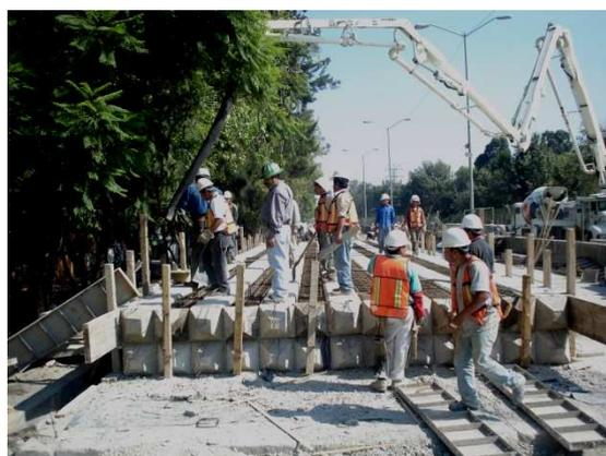
Con este procedimiento se tienen listos los pilotes que serán hincados primero (Tipo "A") enseguida se describirá el proceso constructivo de los pilotes siguientes (Tipo "B").
