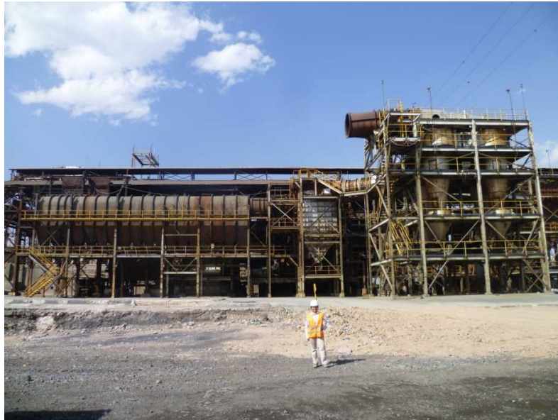
Figura 1.8. Planta de Cu desmantelada, Febrero 2013.
