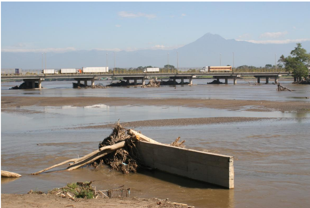
Figura 3.9 Puente internacional Ing. Luís Cabrera
