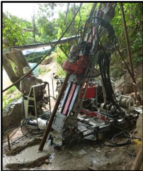
**Fotografía 10.** Equipo para la perforación de barrenos.
