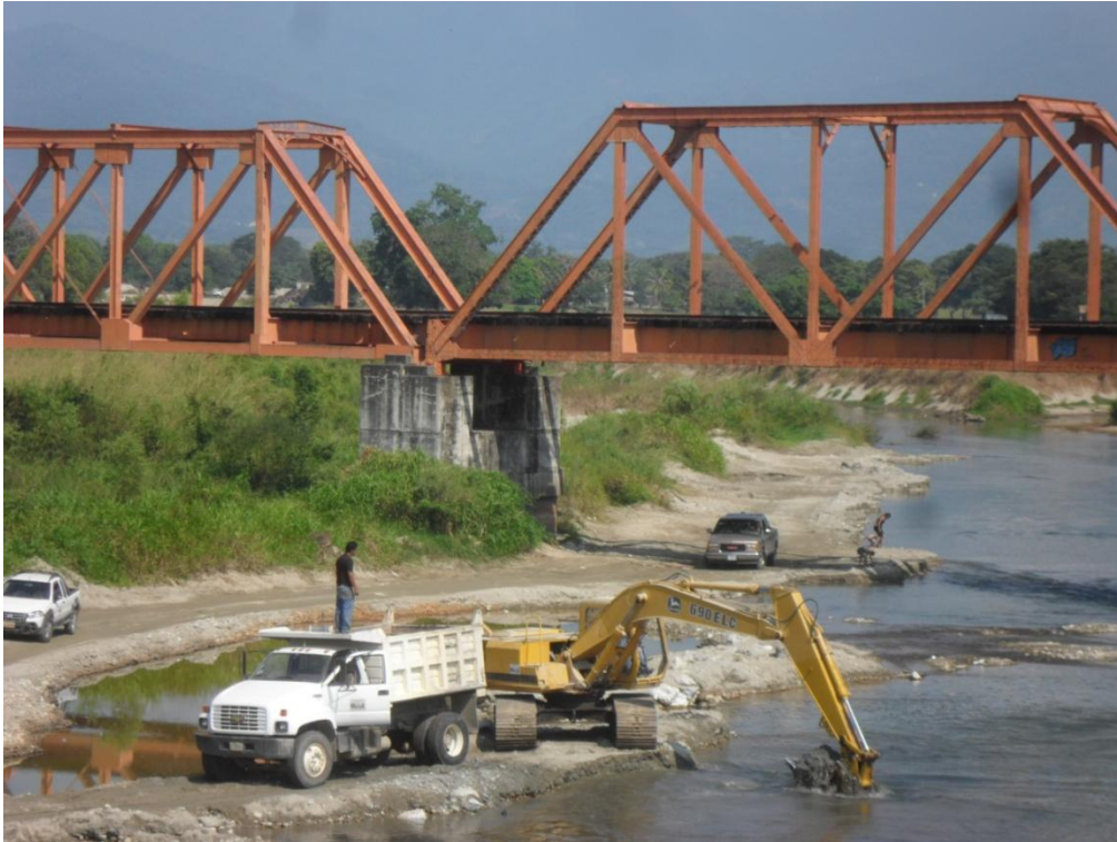
Figura 8.6.4 Dragado del río Cintalapa, Acapetahua
