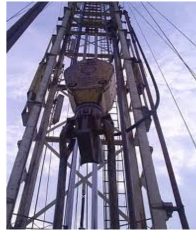
Fig. 4.- Block y torre de perforación
