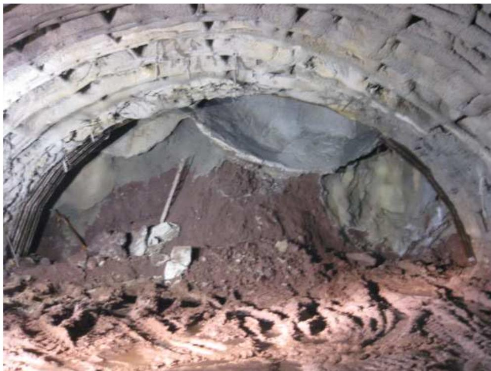
FOTOGRAFIA III. 10. Ejemplo de condición D<sup>(-)</sup>. Túnel “El Sinaloense” portal Mazatlán.
