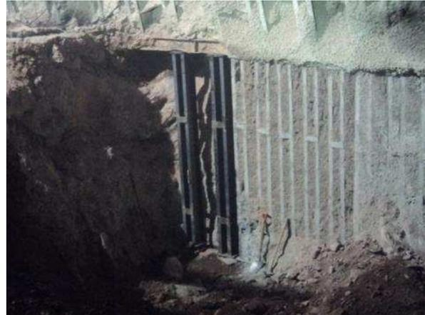
FOTOGRAFÍA IV. 14. Colocación de patas en banqueo.
