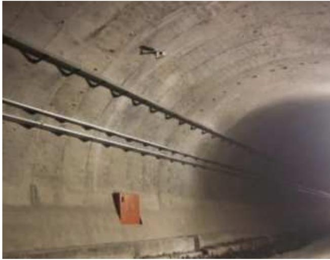
FOTOGRAFÍA IV. 20. Equipos de seguridad; contra incendios, iluminación, cámaras de video.
