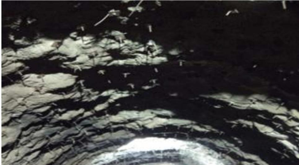
FOTOGRAFÍA IV. 10. Anclas radiales. Interior del túnel “El Sinaloense”
