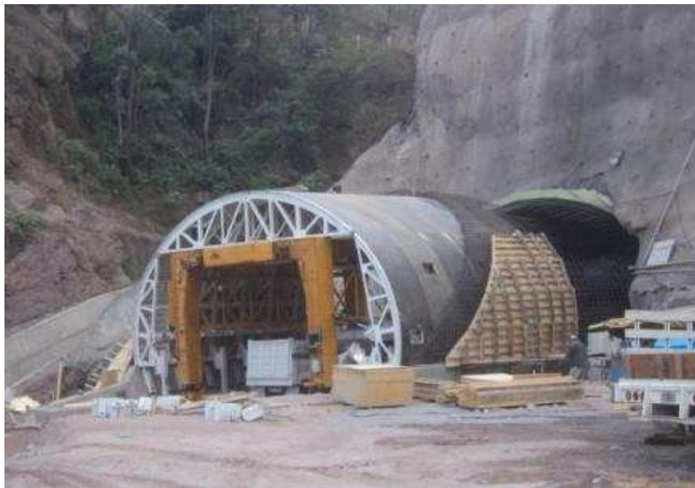
FOTOGRAFÍA IV. 18. Construcción de túnel falso.
