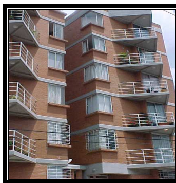
Fig. 2.27 Mampostería libre de repello
