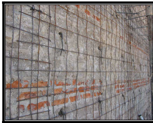
Fig. 2.32 Refuerzo con malla electrosoldada
