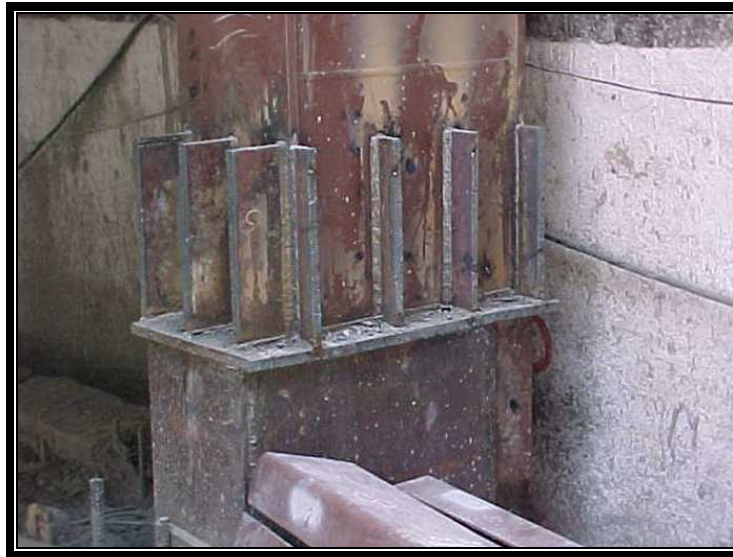
Fig. 2.18 Se puede prefabricar una gran cantidad de piezas en el taller
