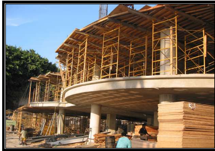
Fig. 2.42 Es necesario el uso de cimbras para darle forma al concreto
