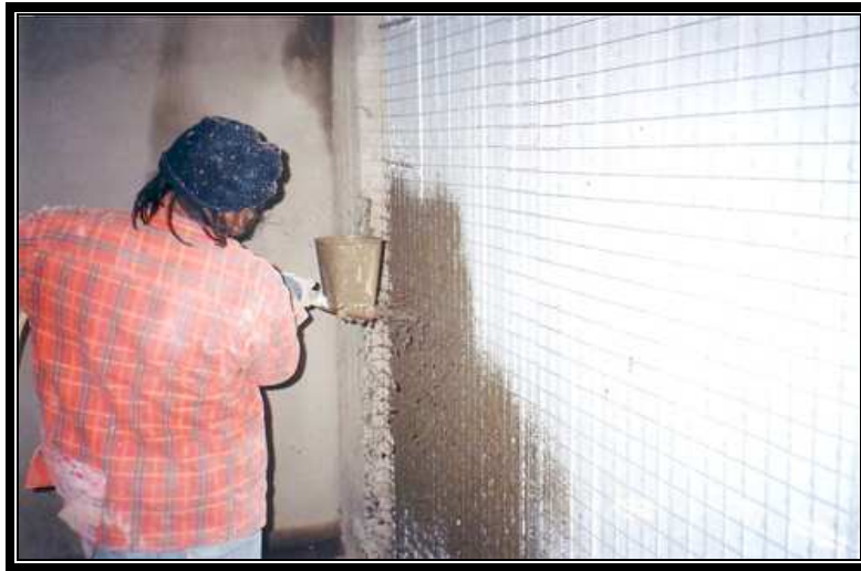
Fig. 2.9 Colocación del mortero en muros hechos con panel
