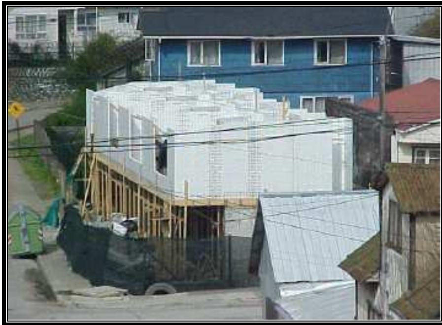
Fig. 2.8 Rapidez para armar y colocar los muros de una vivienda
