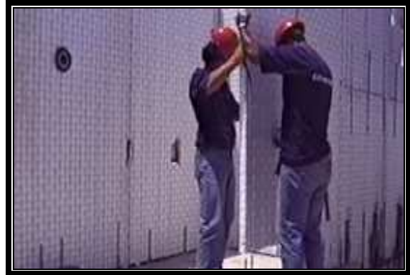
Fig. 2.5 Montaje de muros a la cimentación
