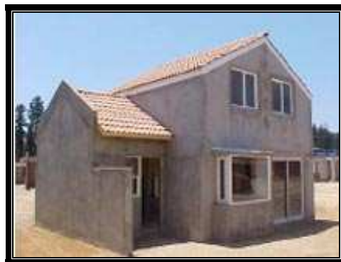
Fig. 2.10 No es recomendable la utilización del panel para viviendas de más de dos niveles
