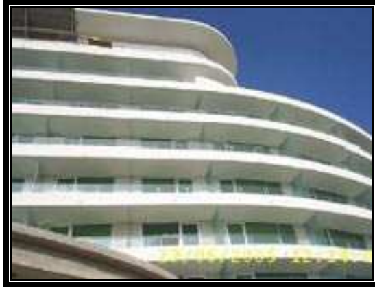
Fig. 2.2 Acabados finales de fachadas en edificación
