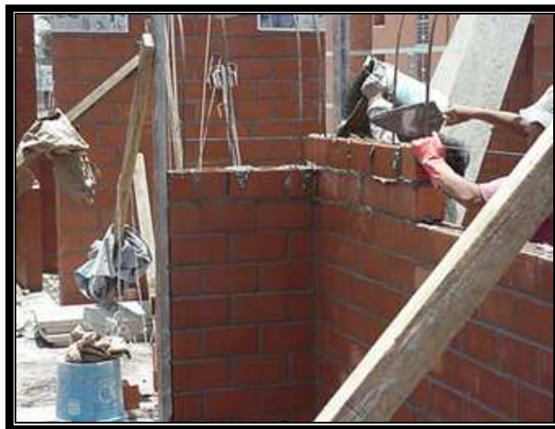
Fig. 2.28 El levantamiento de muros se hace de manera rápida y precisa
