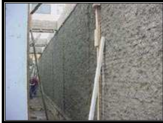
Fig. 2.11 La elaboración del mortero es fundamental en la resistencia del sistema
