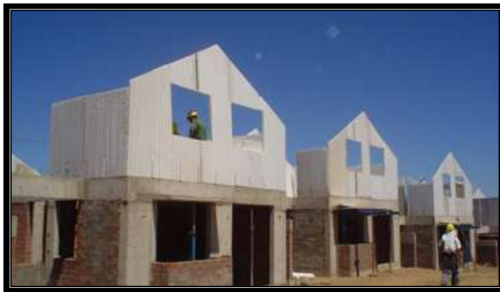
Figura 1.13 Fácil colocación y ensamblado del panel.
