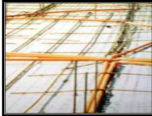
Figura 1.33 Colocación de ductos para instalación eléctrica en losa
