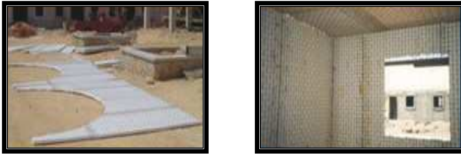
Figura 1.17 Facilidad de corte y ensamble del panel
