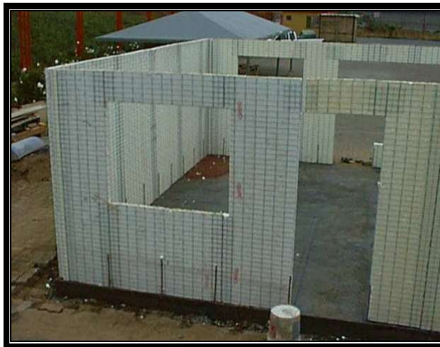
Figura 1.5 Panel estructural armado y ensamblado
