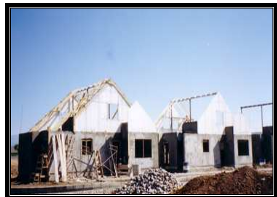
Figura 1.25 Ensamble de vigas y largueros sobre muros de panel estructural
