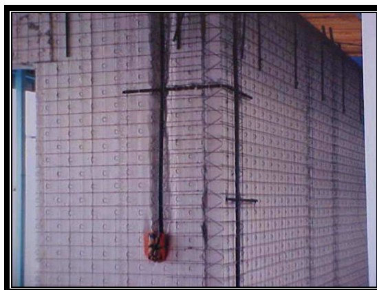
Figura 1.26 Detalle de colocación de instalación eléctrica
