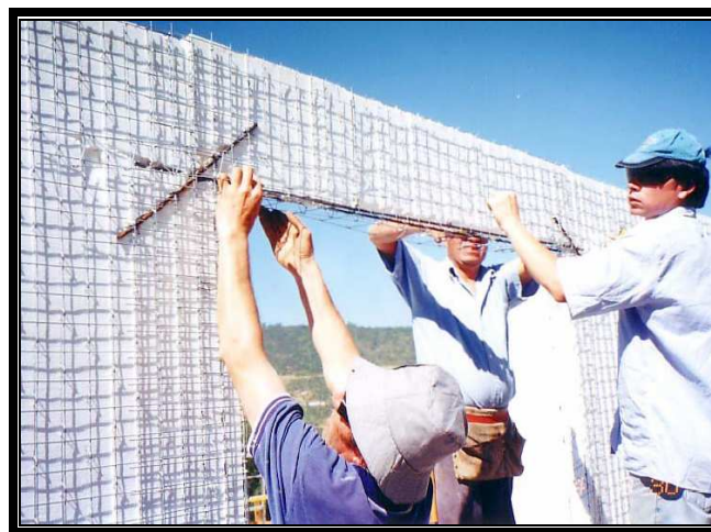
Figura 1.16 Detalle de armado con acero de refuerzo en marco de ventana
