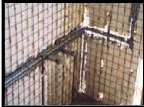
Figura 1.30 Detalle de instalación hidráulica sobre muros
