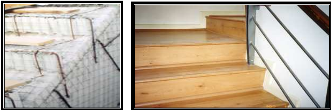
Figura 1.35 Detalle de colocación de acero de refuerzo en escaleras
