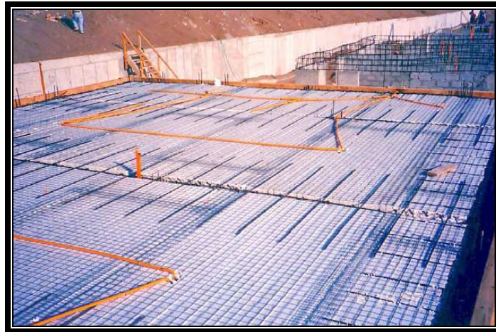
Figura 1.20 Colocación de acero en losa de entrepiso
