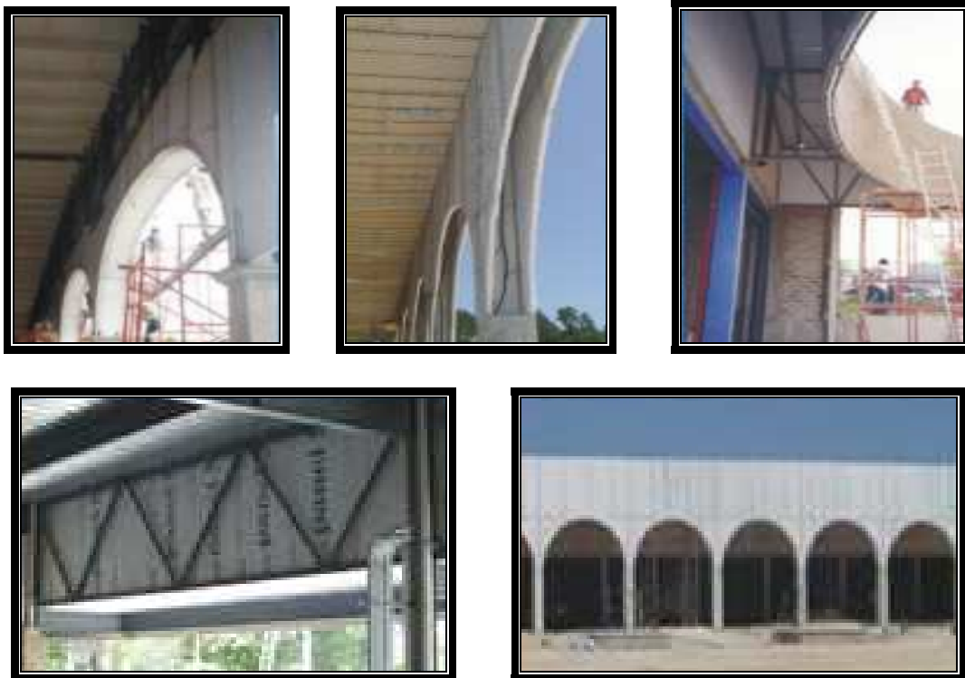
Figura 1.38 Aplicación del panel en pretilas y fachadas principales
