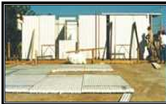
Figura 1.18 Corte y preensablado de panel para losa
