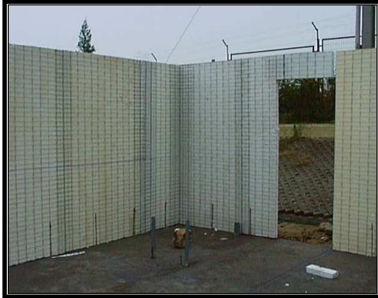
Figura 1.3 Colocación sujeción y armado del panel estructural
