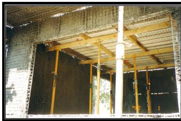
Figura 1.21 Cimbra para soporte de losa de entrepiso
