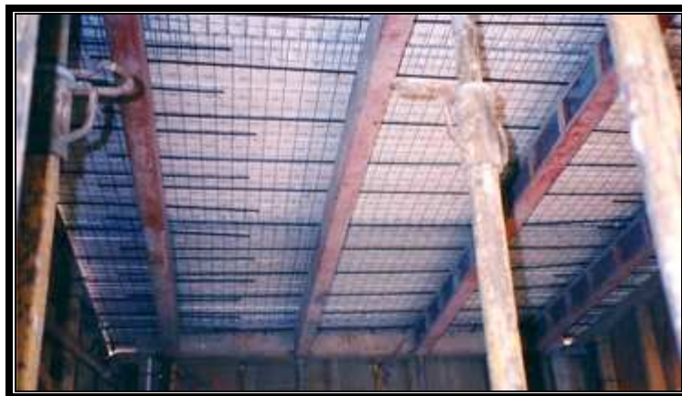
Figura 1.32 Elementos estructurales para el soporte de losa
