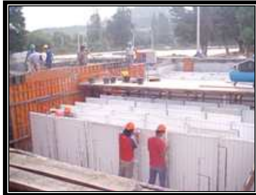
Figura 1.39 Utilización en plantas de tratamiento de agua
