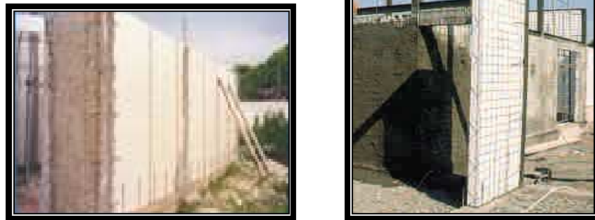
Figura 1.14 Anclaje del panel estructural a cimentación
