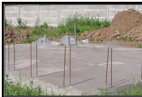
Figura 1.4 Colocación del acero de refuerzo para sujetar el panel a la cimentación
