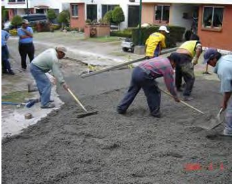
Figura 26. Acomodo de la mezcla con rastrillos y palas
