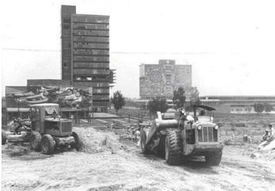
Figura 32. Construcción de la Ciudad Universitaria
