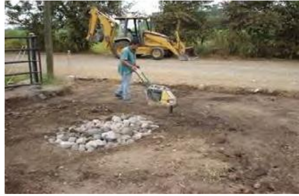
Figura 23. Pozo de absorción relleno con boleos
