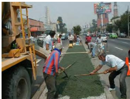
Figura 21. Colocación de concreto permeable en camellones de la ciudad de México
