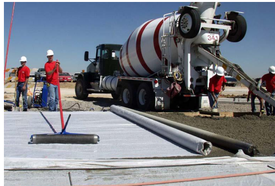
Figura 25. Camión revolventora, especial para concreto permeable
