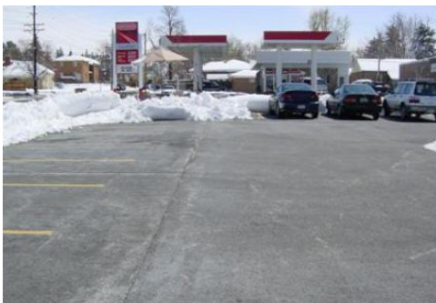
Figura 19. Funcionamiento del concreto permeable en un estacionamiento bajo condiciones de congelación y deshielo
