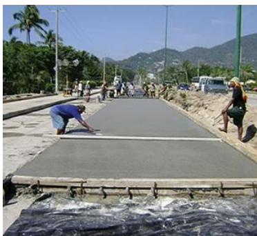
Fig. 10. Aplicación de concreto convencional.
