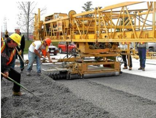
Fig. 9. Una buena instalación provee un buen funcionamiento del concreto permeable
