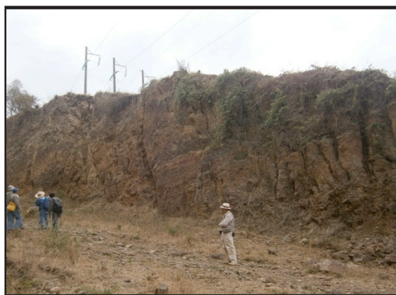
Figura 3.32 Zona con amplias grietas de tensión creadas por deslizamiento en Zona Dorada Ocolusen, intercalaciones de brecha volcánica con derrames de andesita.
