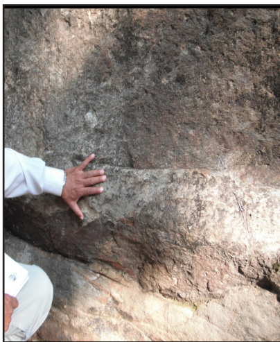
Figura 3.37 Plano de falla sobre el río pequeño, presencia de estrías de falla.
