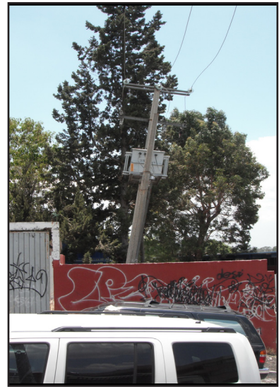
Figura 3.43 Poste inclinado como evidencia de movimiento en la zona de deposito del deslizamiento.
