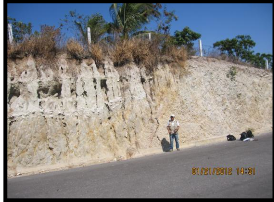
Fig. A34 Se observa el contacto entre tres tipos de litologías (arenas, granodiorita y gneiss) por fallamiento.
