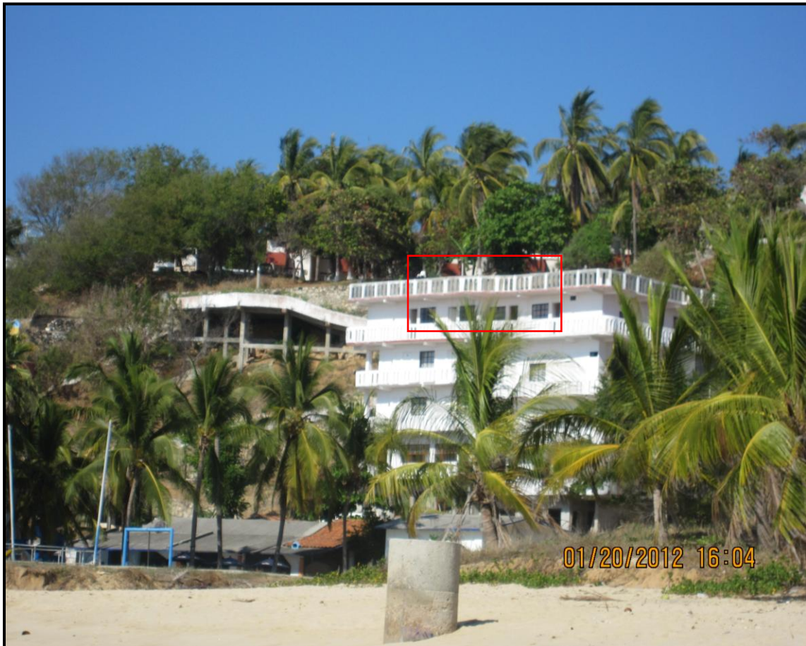
Fig. 5.1 Deformación de construcciones en Playa Coral, Puerto Escondido, Oaxaca.
