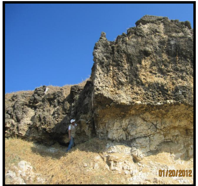
Fig. A11 Toma de datos estructurales.
