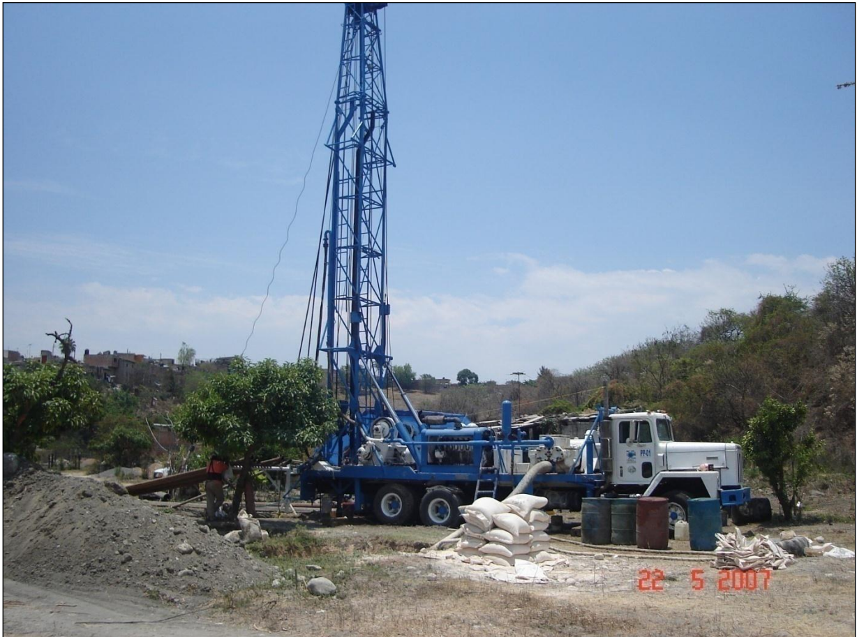
Equipo de perforación tipo rotario
