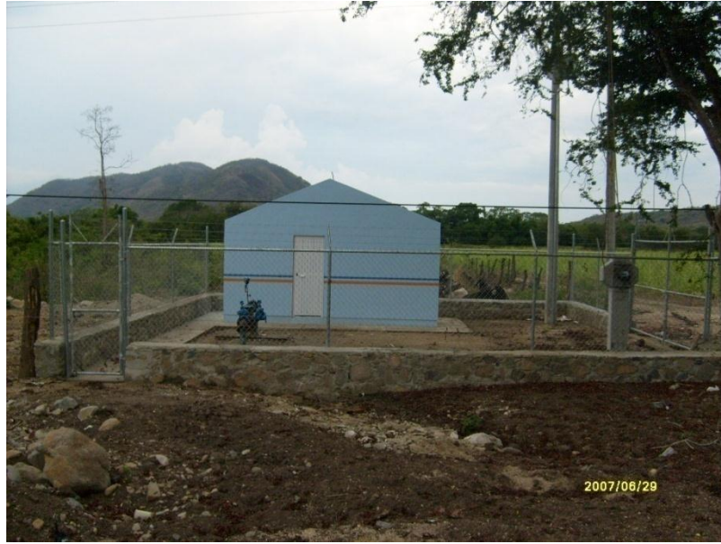
Cerco perimetral y caseta de controles
