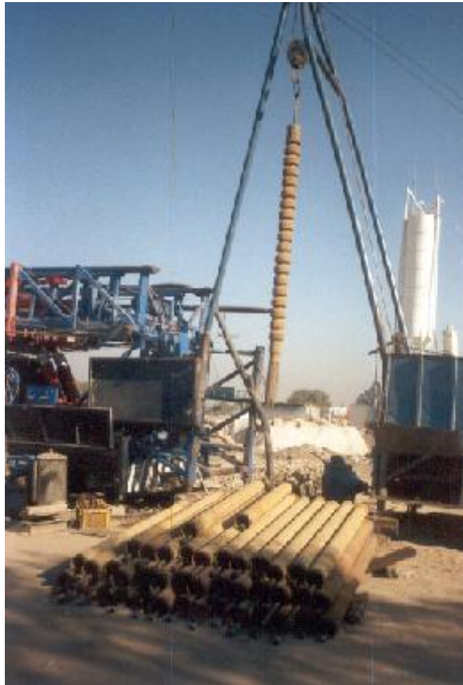
Bomba tipo turbina y columna
