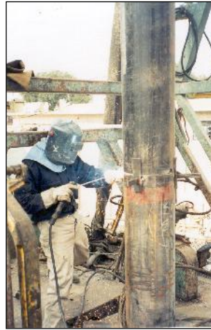
Instalación tubería de ademe
