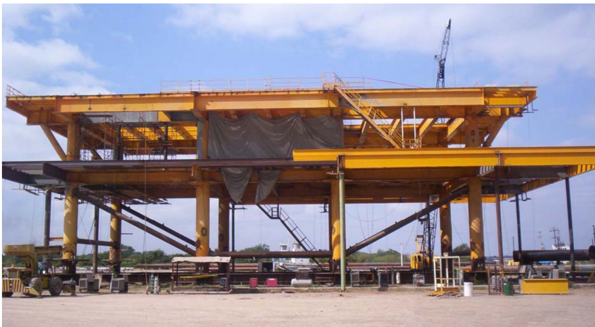
FOTOGRAFÍA 5.2 LA SUPERESTRUCTURA DE ABKATUN-I TRASLADADA A LOS PATIOS DE CONSTRUCCIÓN EN TUXPAN, VERACRUZ, YA EN ETAPA DE ADECUACIÓN PARA SU POSTERIOR INSTALACIÓN EN EL SITIO YAXCHÉ-A
