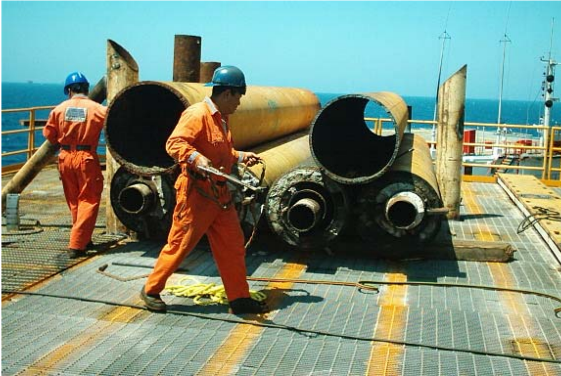
FOTOGRAFÍA 5.1 COLOCACIÓN DE UN CONTRAPESO DE 43 TON PARA POSICIONAR EL C.G. EN EL CENTRO GEOMÉTRICO DE LA SUPERESTRUCTURA
