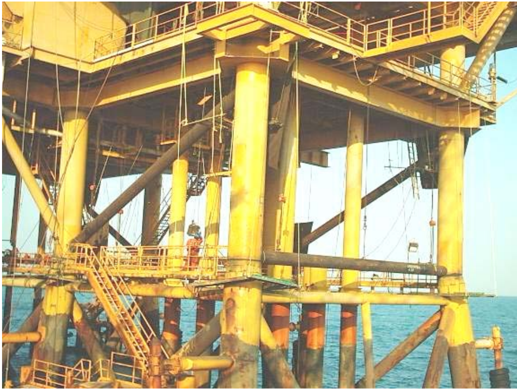
FOTOGRAFÍA 4.36 VISTA PARCIAL DE LA COLOCACIÓN DE LOS ELEMENTOS TEMPORALES
