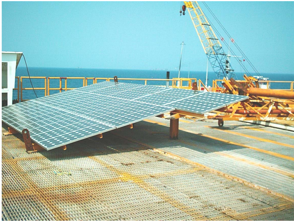
FOTOGRAFÍA 4.7 PANEL DE CELDAS SOLARES ANTES DE SER RETIRADO
