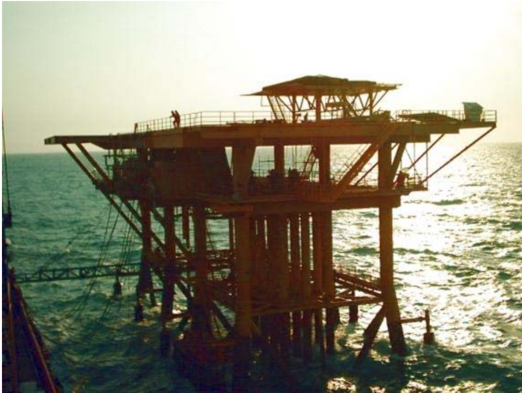
FOTOGRAFÍA 4.1 LA PLATAFORMA ABKATUN-I AL INICIO DE LOS TRABAJOS PARA LA RECUPERACIÓN DE SU SUPERESTRUCTURA.
