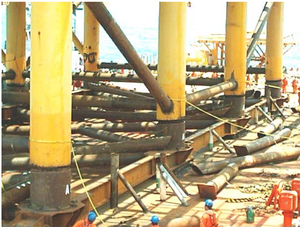
FOTOGRAFÍA 4.48 DEBIDO A QUE EL ESPESOR DE LAS COLUMNAS EXTERIORES RESULTARON DIFERENTE AL QUE SE CONSIDERÓ EN EL PROYECTO (ver Conclusiones), NO AJUSTARON COMPLETAMENTE EN LOS CASQUILLOS, POR LO QUE SE DECIDIÓ IZAR NUEVAMENTE LA SUPERESTRUCTURA
