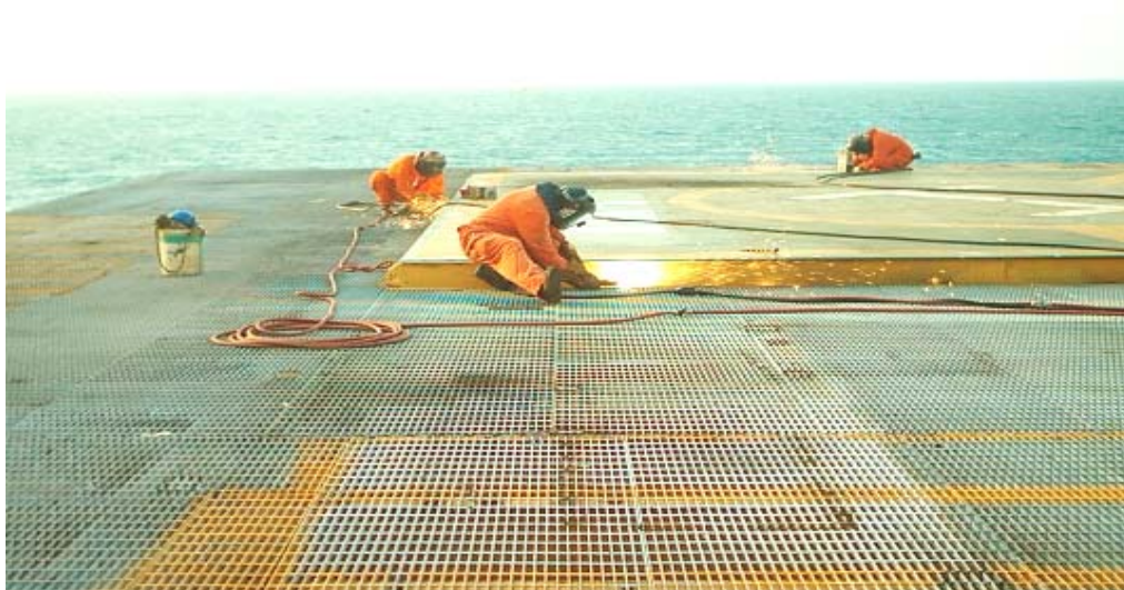
FOTOGRAFÍA 4.9 CORTE DE LA UNIÓN ENTRE LA ESTRUCTURA DEL HELIPUERTO Y LAS VIGAS DE LA CUBIERTA SUPERIOR
