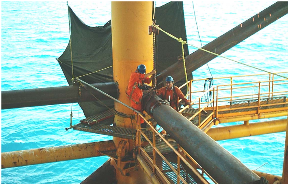
FOTOGRAFÍA 4.35 ELEMENTOS TEMPORALES ADICIONALES PARA IZAJE
