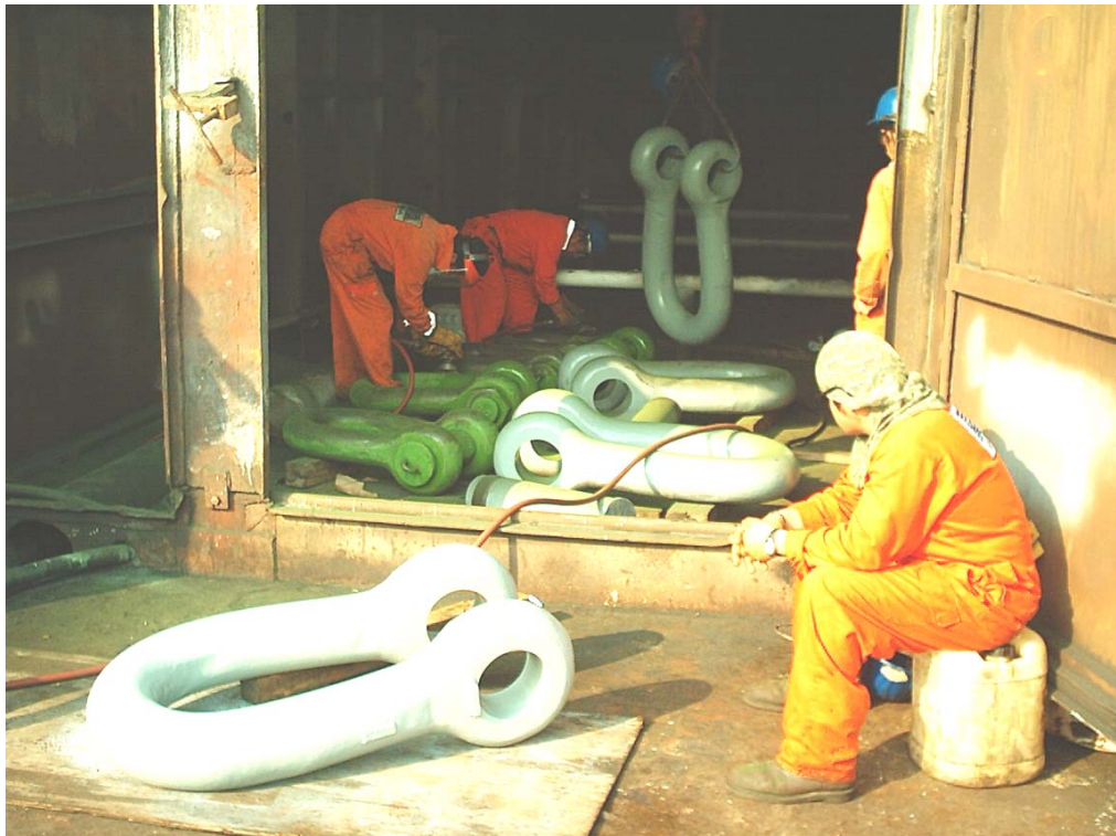
FOTOGRAFÍA 4.41 PREPARACIÓN DE LOS GRILLETES PARA IZAJE
