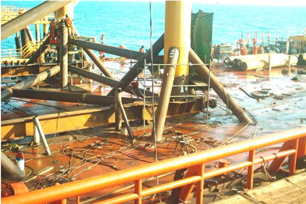
FOTOGRAFÍA 4.53 UNA VEZ ACOPLADA LA SUPERESTRUCTURA EN EL MARCO SOPORTE, SE PROCEDIÓ A COLOCAR LOS PUNTALES DE AMARRE PARA TRANSPORTACIÓN
