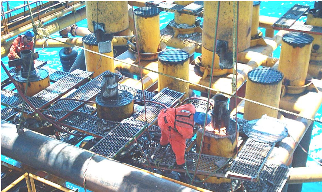
FOTOGRAFÍA 4.17 SELLADO DE LOS POZOS, PARA COLOCAR POSTERIORMENTE UNA TAPA METÁLICA
