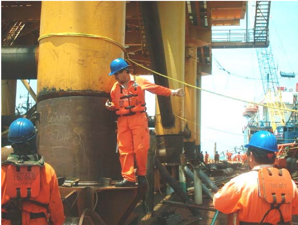
FOTOGRAFÍA 4.51 REVISIÓN DETALLADA DEL CONTACTO PIERNA-CASQUILLO
