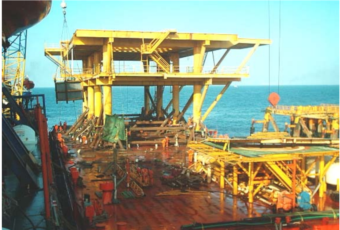
FOTOGRAFÍA 4.55 POSICIÓN FINAL DE LA SUPERESTRUCTURA Y ACCESORIOS EN EL CHALÁN DE TRANSPORTACIÓN
