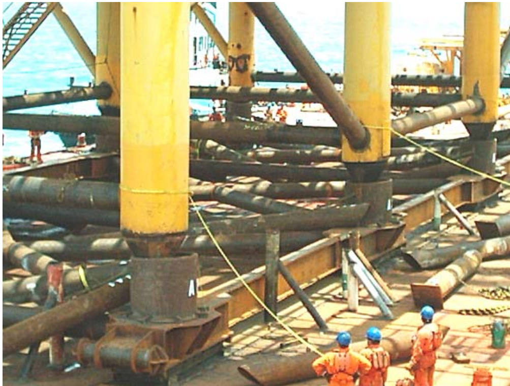
FOTOGRAFÍA 4.47 LAS GUÍAS DE ACOPLAMIENTO SE INTRODUCEN EN LOS CASQUILLOS DEL MARCO SOPORTE
