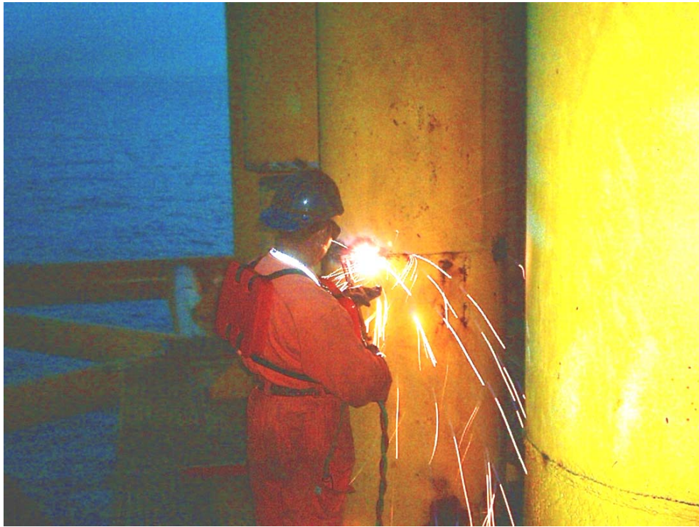
FOTOGRAFÍA 4.10 CORTE INICIAL DE UNO DE LOS CONDUCTORES DE CRUDO DE 30" Ø
