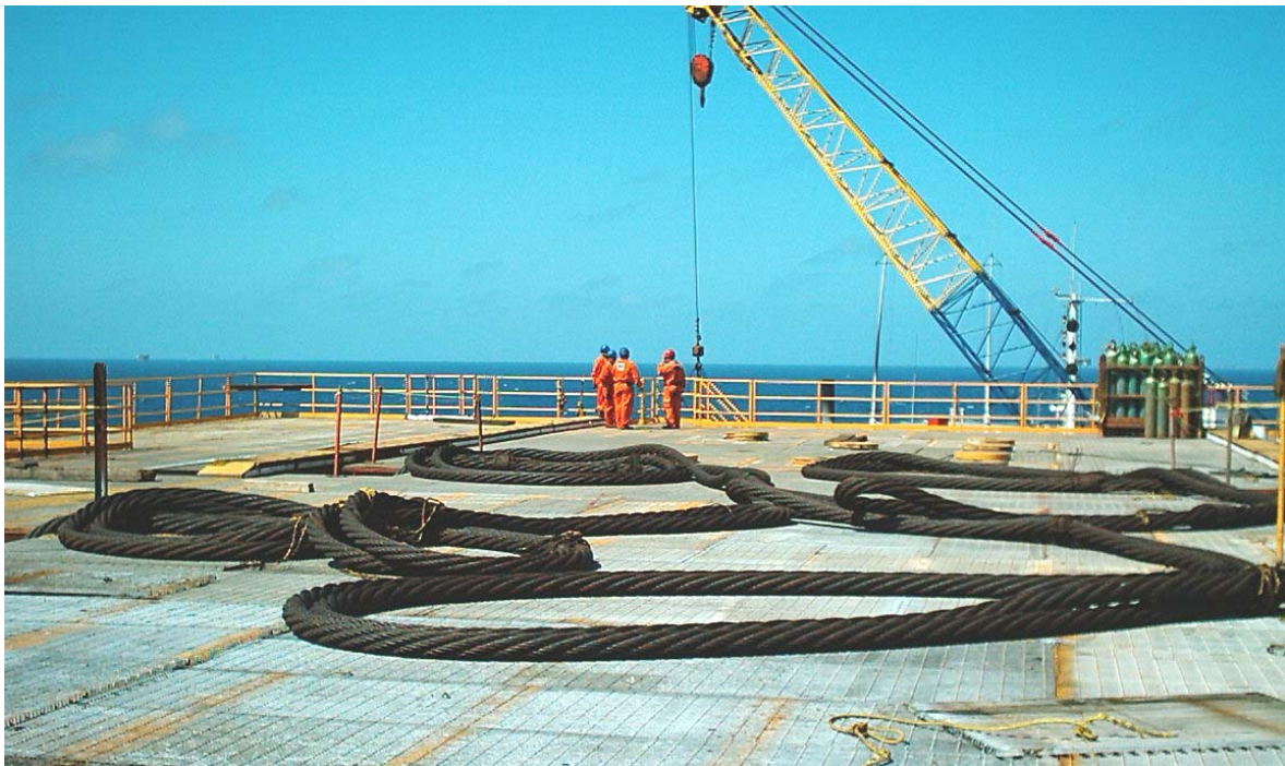
FOTOGRAFÍA 4.43 CABLES DE IZAJE COLOCADOS EN LA CUBIERTA SUPERIOR DESPEJADA
