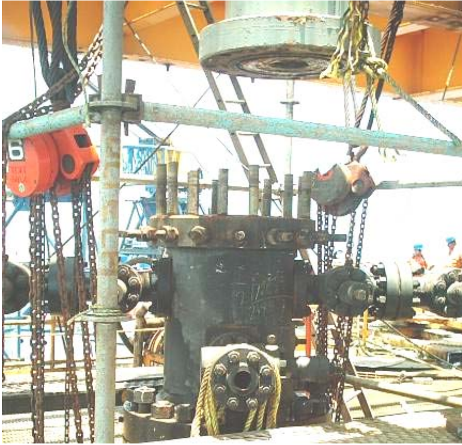
FOTOGRAFÍA 4.14 RETIRO DE LA TAPA DEL ÁRBOL DE VÁLVULAS, PARA INSPECCIÓN DEL POZO PREVIO AL CORTE DEL TUBO CENTRAL
