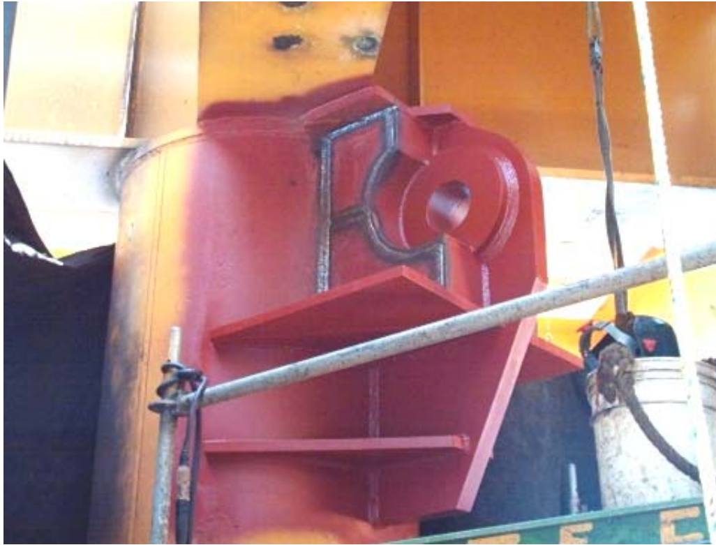
FOTOGRAFÍA 4.38 PROTECCIÓN ANTICORROSIVA PRIMARIA A LAS OREJAS DE IZAJE REFORZADAS
