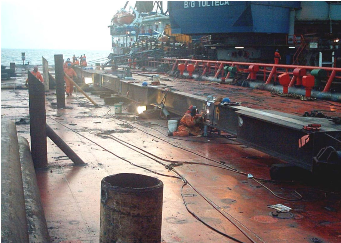
FOTOGRAFÍA 4.26 VIGAS DEL EJE A DEL MARCO SOPORTE
