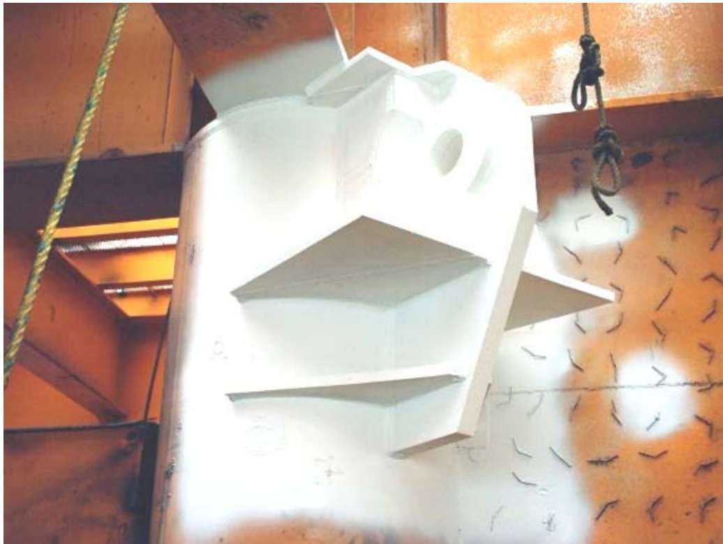
FOTOGRAFÍA 4.39 PINTURA BASE EN OREJA DE IZAJE REFORZADA
