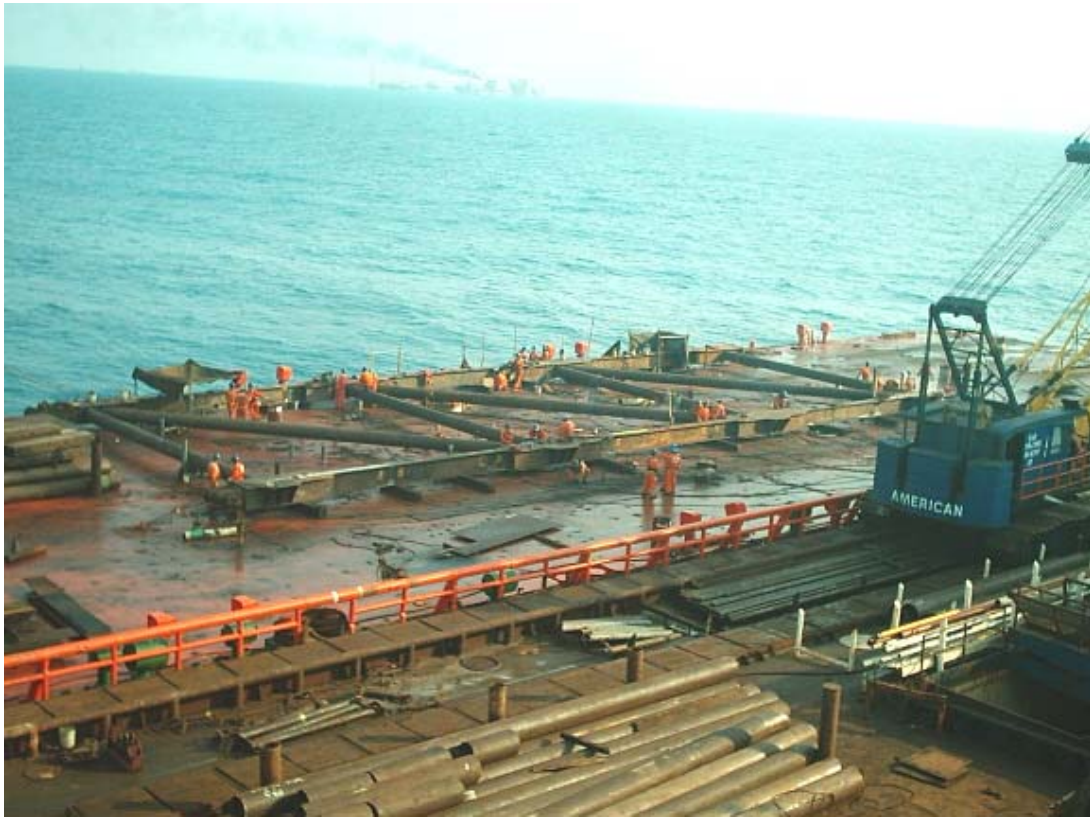
FOTOGRAFÍA 4.28 COLOCACIÓN DE LA TUBERÍA TRANSVERSAL DEL MARCO SOPORTE.
