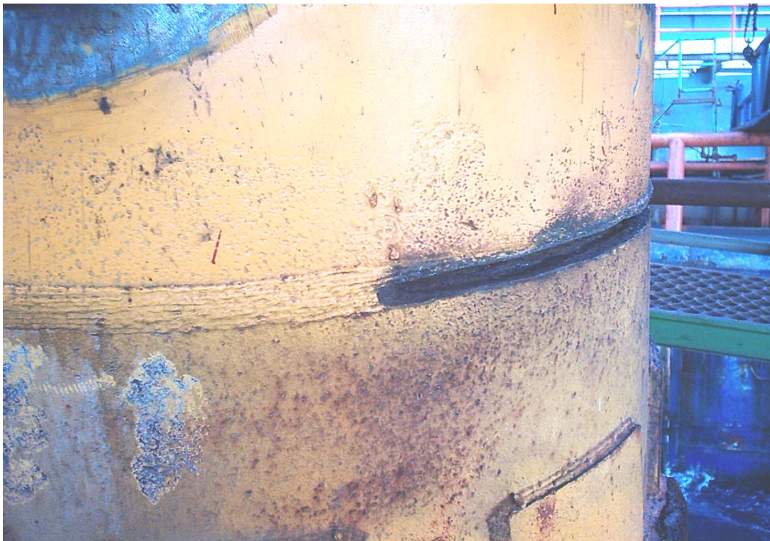
FOTOGRAFÍA 4.21 DETALLE DE LA SOLDADURA REMOVIDA DEL PUNTO DE TRABAJO
