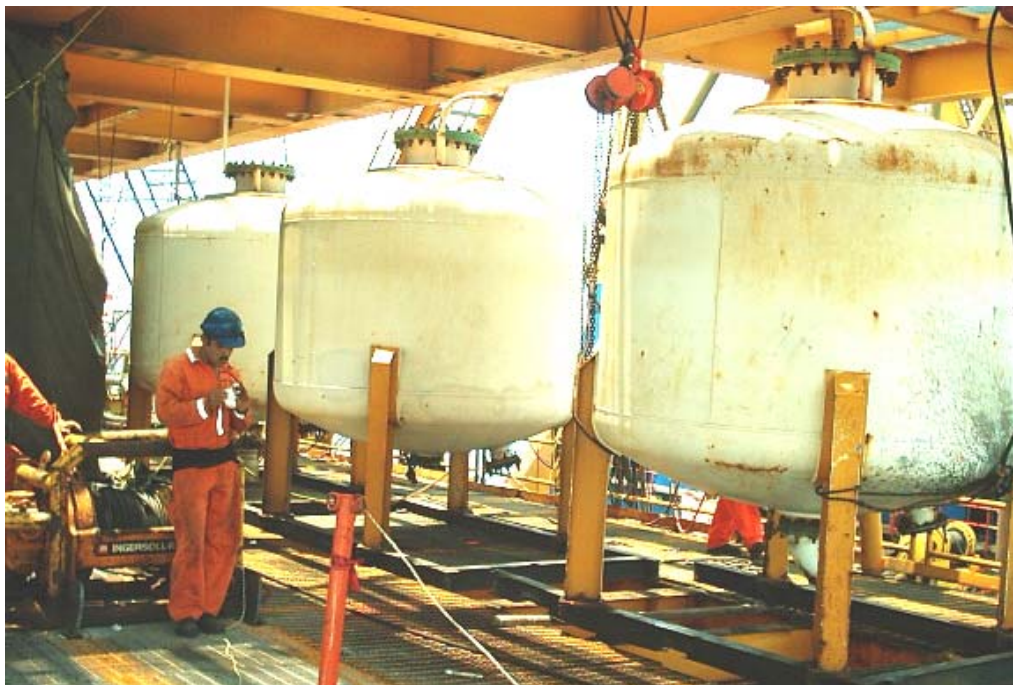
FOTOGRAFÍA 4.3 DESMONTAJE Y RETIRO DE EQUIPOS Y TANQUES
