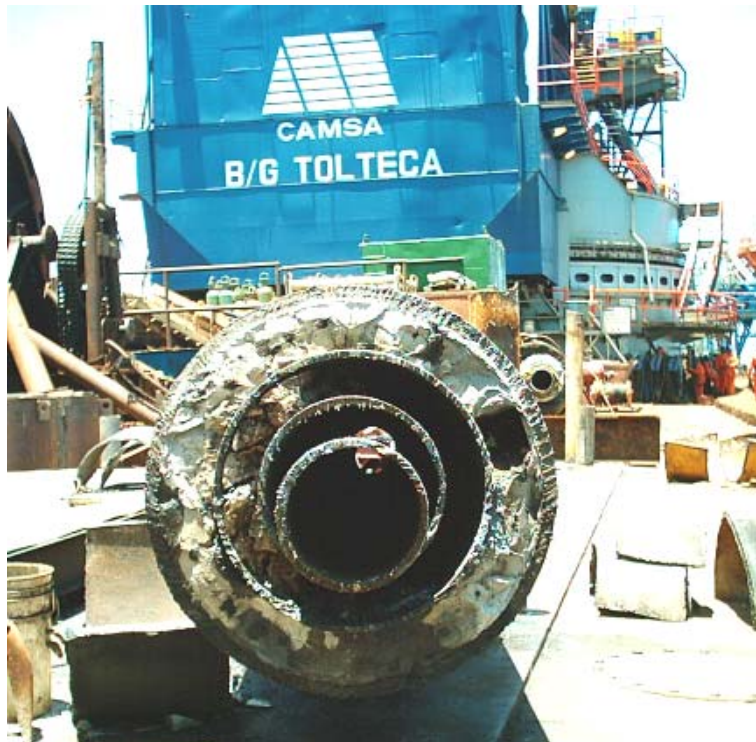
FOTOGRAFÍA 4.19 SECCIÓN TRANSVERSAL DE LA TUBERÍA RETIRADA DEL POZO DE PRODUCCIÓN
