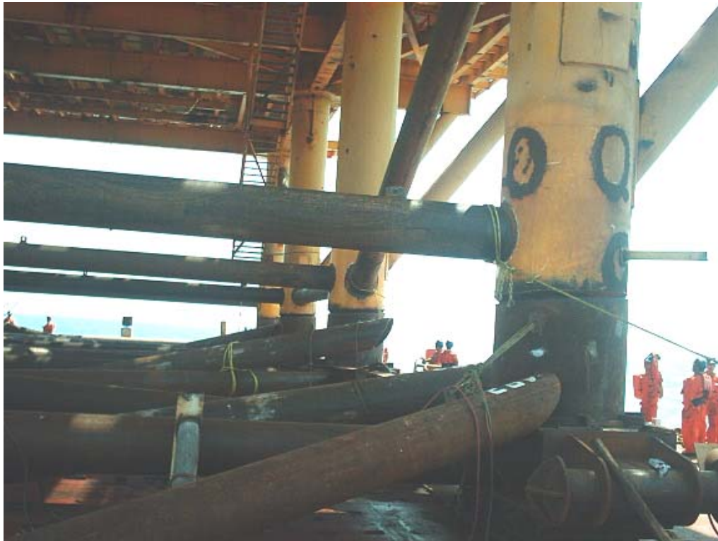
FOTOGRAFÍA 4.52 EL ACOPLAMIENTO FINALMENTE ES ADECUADO EN TODAS LAS COLUMNAS
