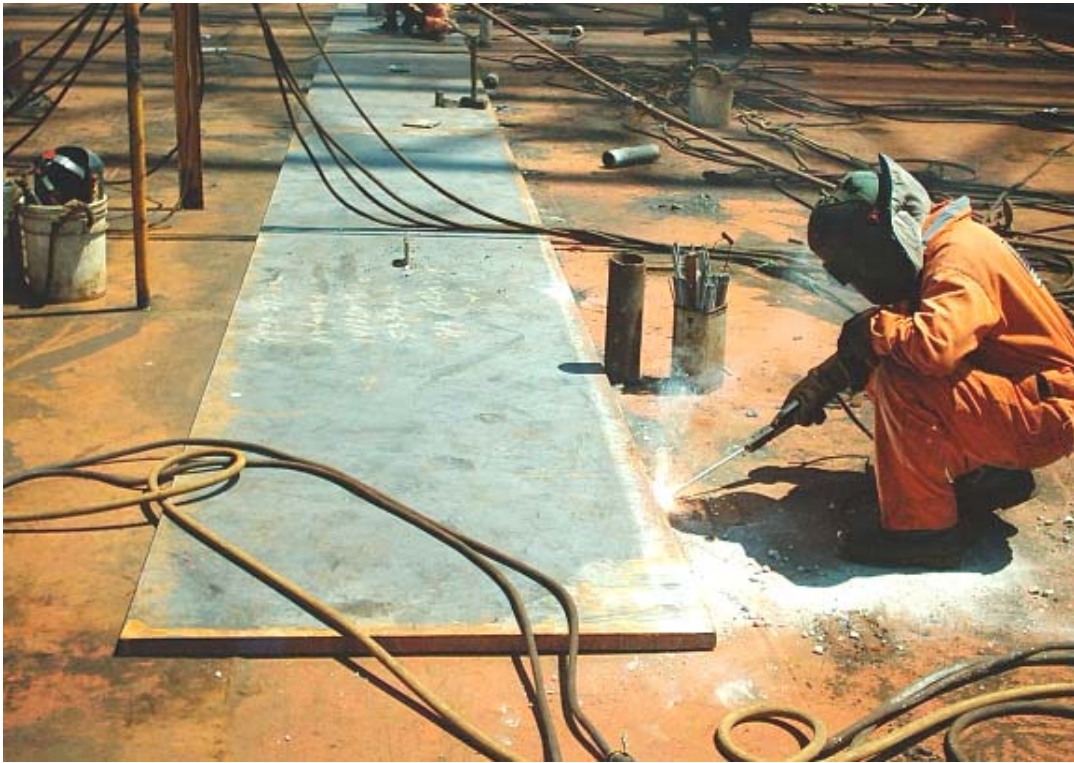
FOTOGRAFÍA 4.32 COLOCACIÓN DE PLACA DE DESLIZAMIENTO
