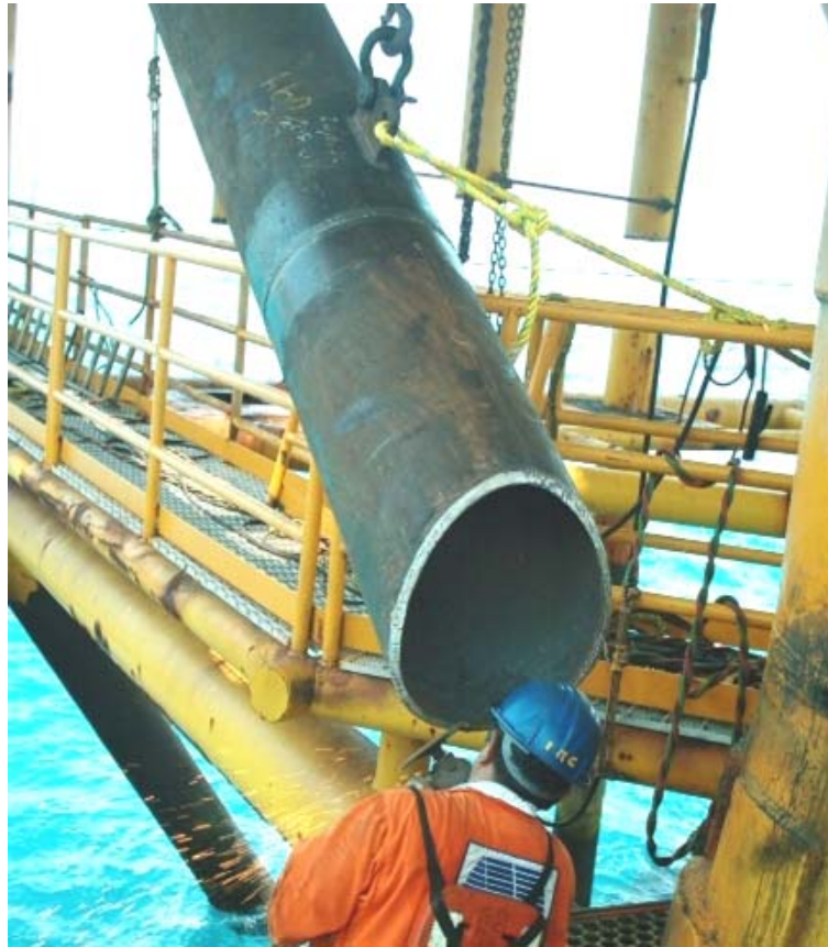
FOTOGRAFÍA 4.34 PRESENTACIÓN Y DETALLADO DE ELEMENTOS DE REFUERZO PARA EL IZAJE
