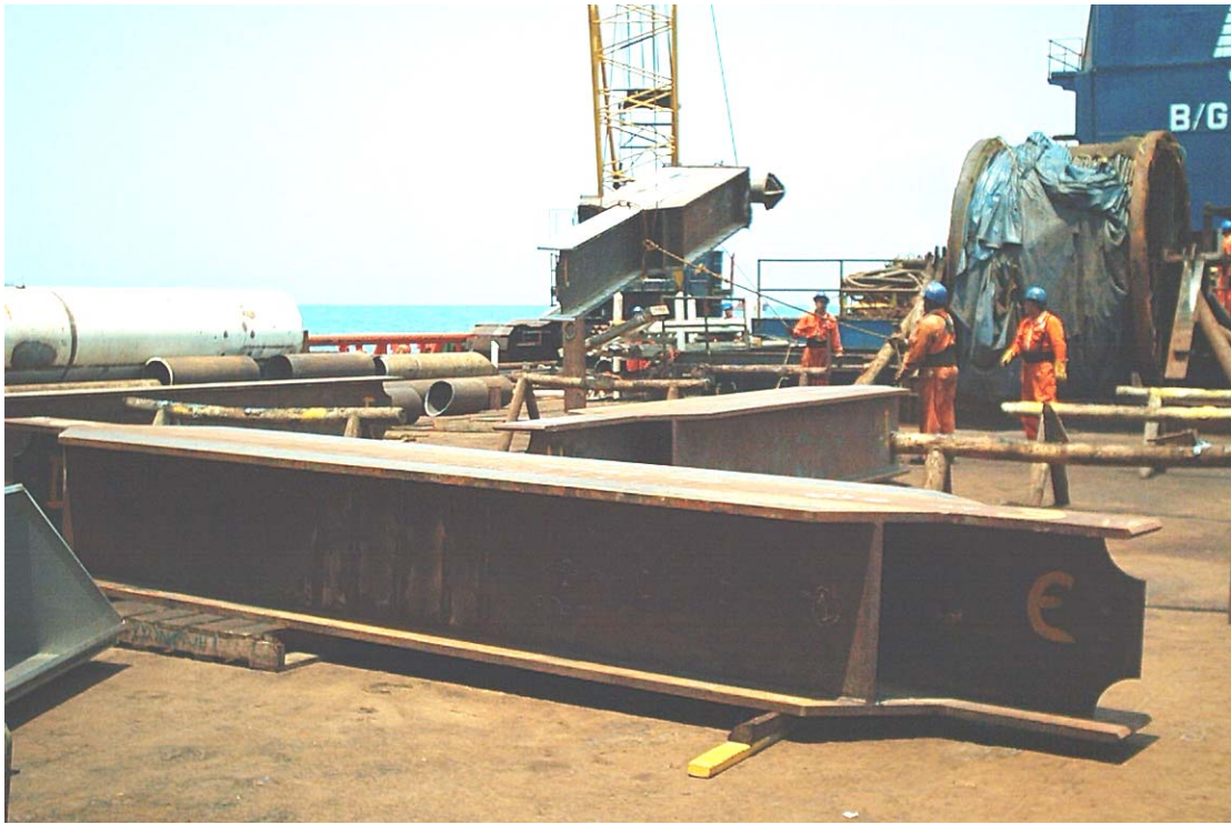
FOTOGRAFÍA 4.24 TRASLADO DE LAS SECCIONES DEL MARCO SOPORTE DE LA SUPERESTRUCTURA, AL CHALÁN DE TRANSPORTE
