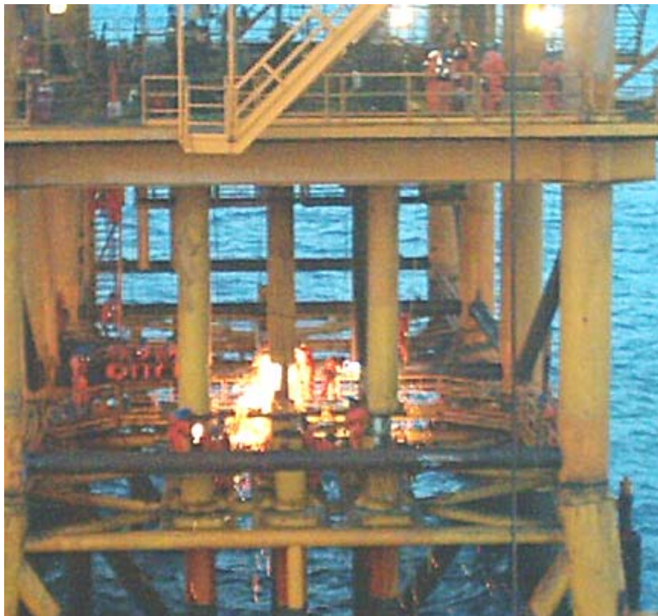
FOTOGRAFÍA 4.13 CORTE DEL TUBO INTERIOR DE 20" DE DIÁMETRO DEL POZO DE PRODUCCIÓN
