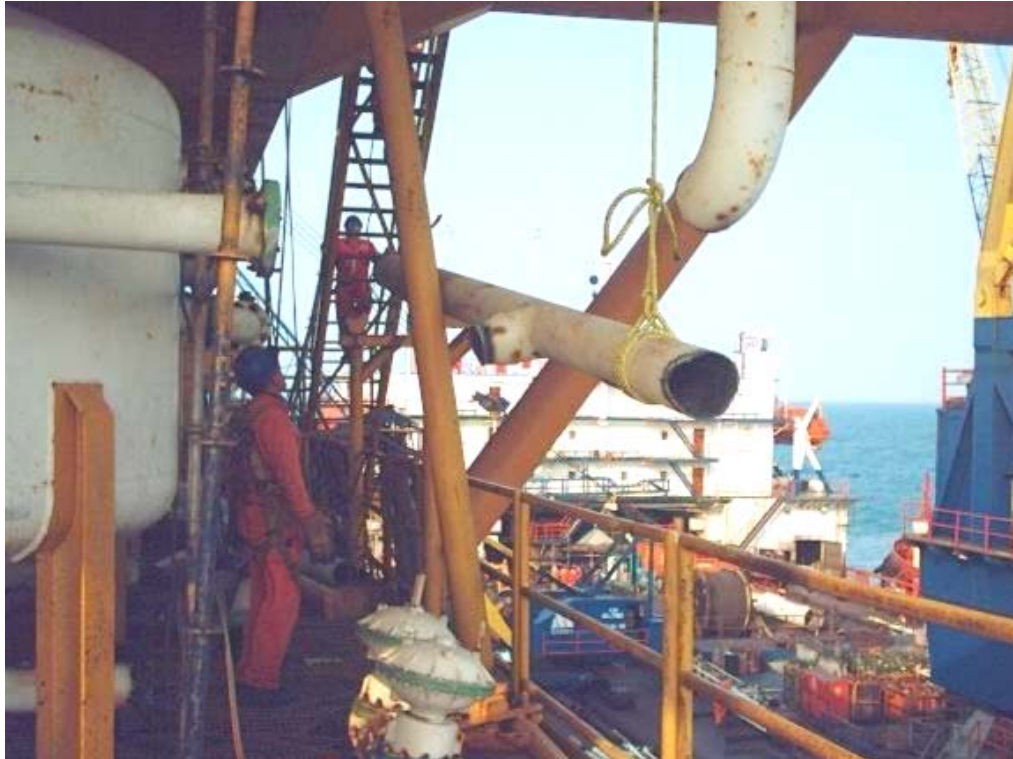
FOTOGRAFÍA 4.2 RETIRO DE TODA TUBERÍA DE PROCESO Y DE SERVICIOS
