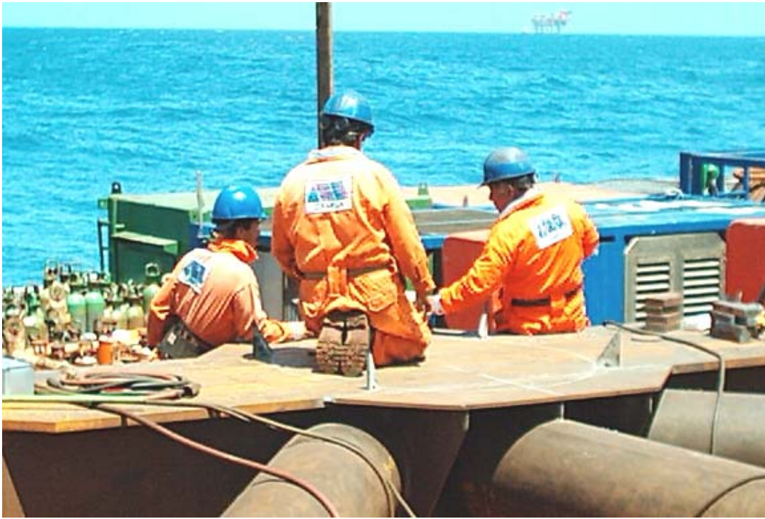
FOTOGRAFÍA 4.30 GUÍAS PARA COLOCAR LOS CASQUILLOS DEL MARCO
