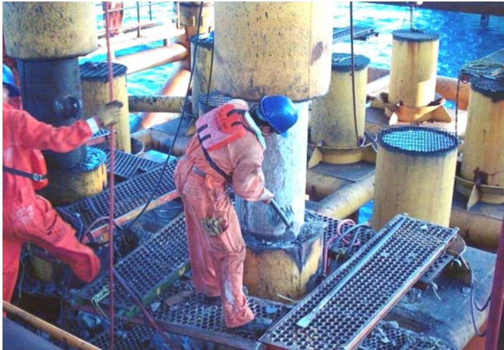
FOTOGRAFÍA 4.12 PREPARACIÓN PARA CORTE DEL TUBO INTERIOR DE 20" DE DIÁMETRO DEL POZO DE PRODUCCIÓN
