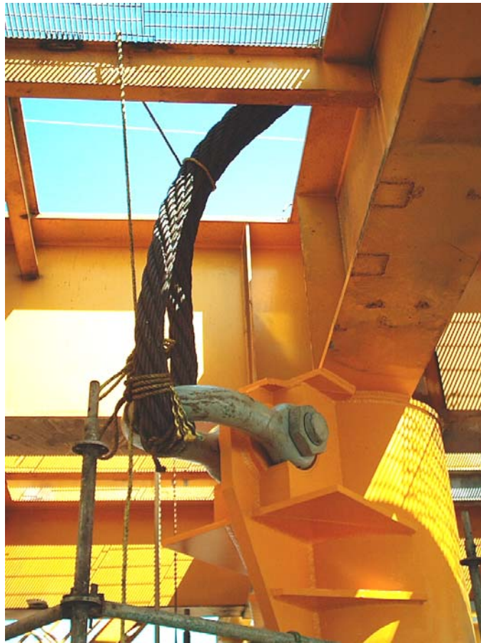
FOTOGRAFÍA 4.42 COLOCACIÓN DE LOS CABLES Y GRILLETES
