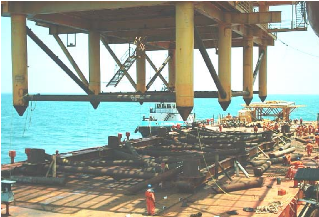
FOTOGRAFÍA 4.46 APROXIMACIÓN DE LA SUPERESTRUCTURA AL CHALAN
