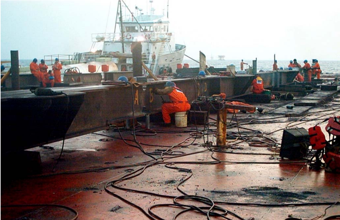
FOTOGRAFÍA 4.27 VIGAS DEL EJE B DEL MARCO SOPORTE
