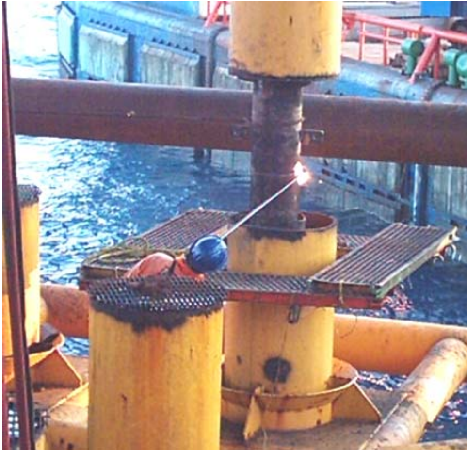
FOTOGRAFÍA 4.16 CORTE A DISTANCIA DE LOS TUBOS CENTRALES DEL POZO DE PRODUCCIÓN
