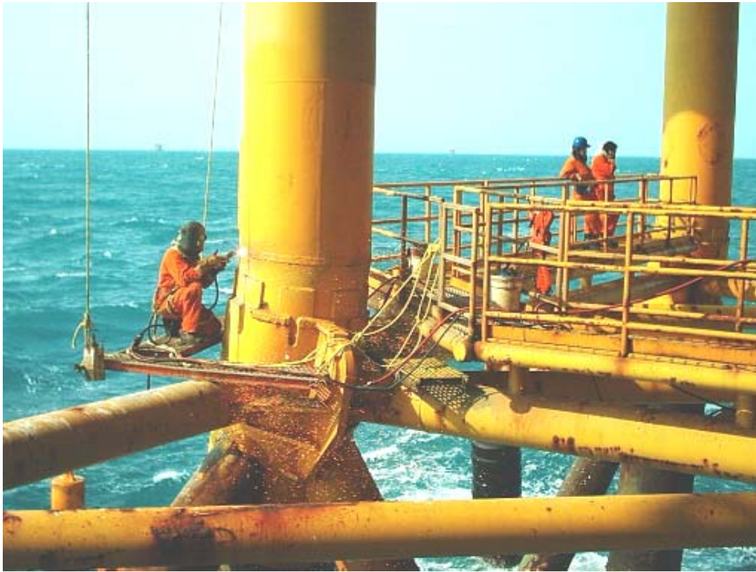
FOTOGRAFÍA 4.20 CORTE DE SOLDADURA EN EL PUNTO DE TRABAJO DE LA UNIÓN COLUMNA-PILOTE
