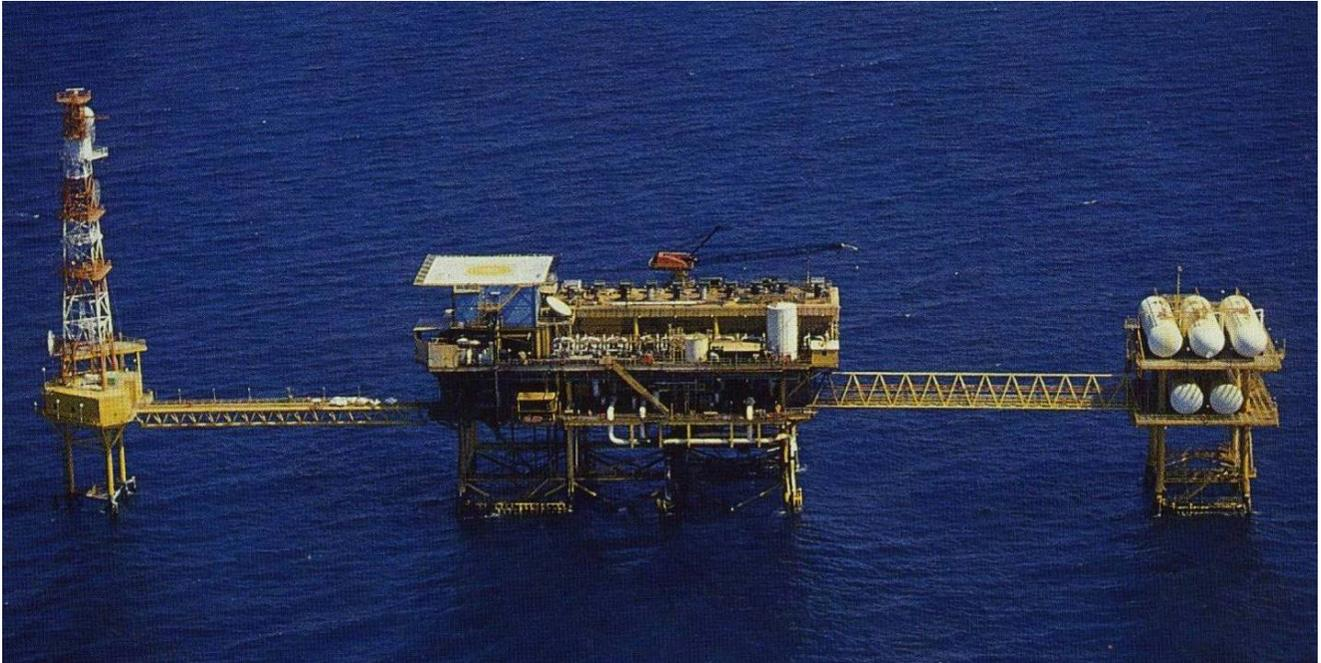
FIG. 1.7 EN EL COMPLEJO DE REBOMBEO, HAY UN TRÍPODE DE COMUNICACIONES, UN OCTÁPODO PARA OPERACIONES Y UN TETRÁPODO DE ALMACENAMIENTO.
