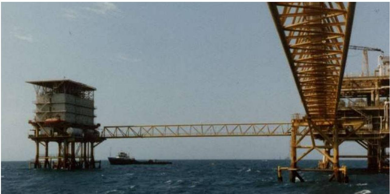
FIG 1.8 UNA PLATAFORMA HABITACIONAL ENLAZADA POR PUENTES A LA ZONA DE PERFORACIÓN, PRODUCCIÓN Y TRATAMIENTO.
