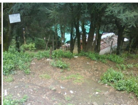
Figura 4.4 b) áreas lavadas por erosión
