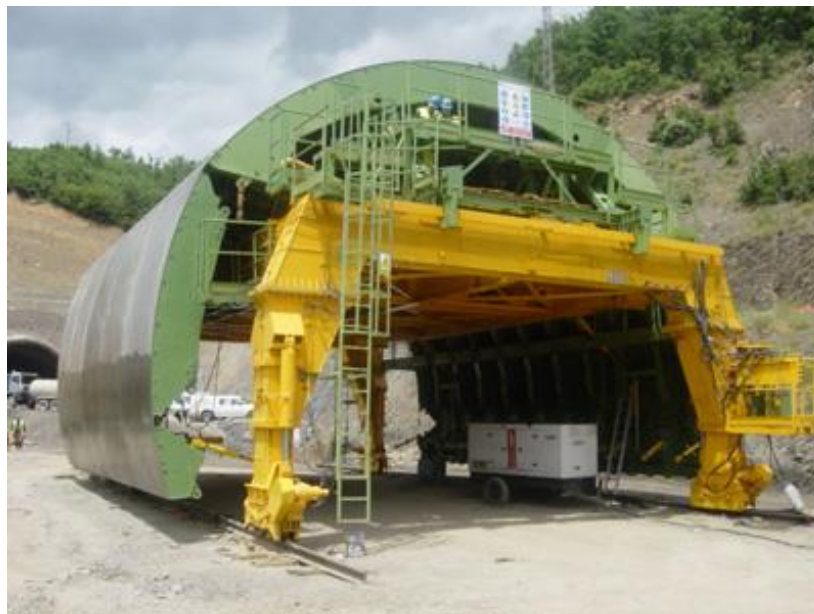
Figura 38. Carro de encofrado.
