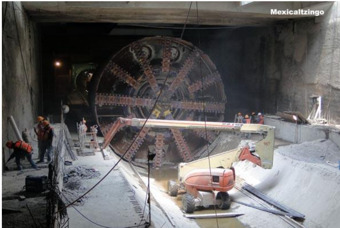
Figura 40. Escudo de Presión Balanceada ( EPB )
