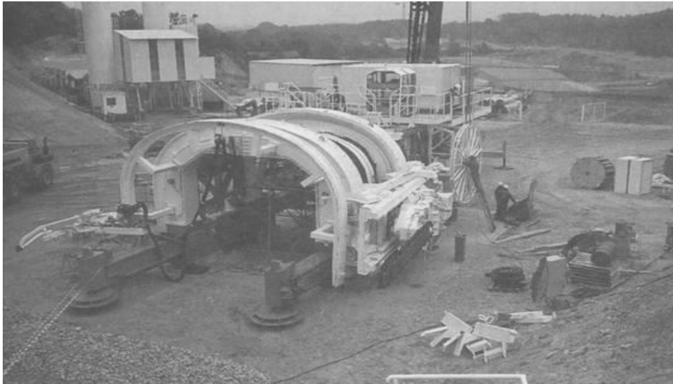
Figura 34. Construcción de túnel de precorte mecánico.
