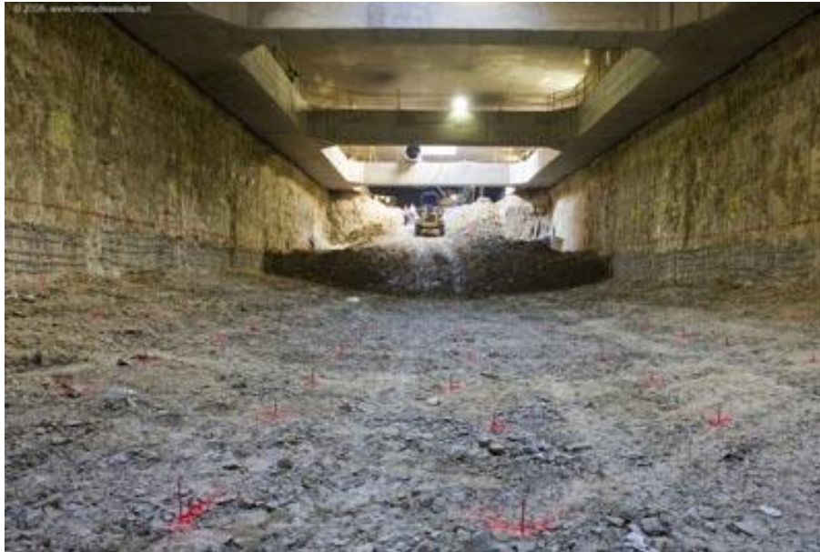
Figura 32. Construcción de falso túnel.
