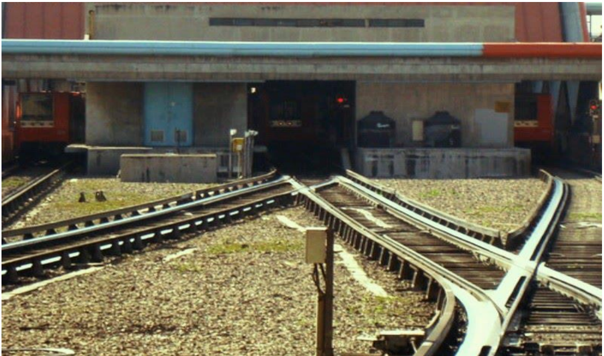
Figura 8. Talleres del METRO.
