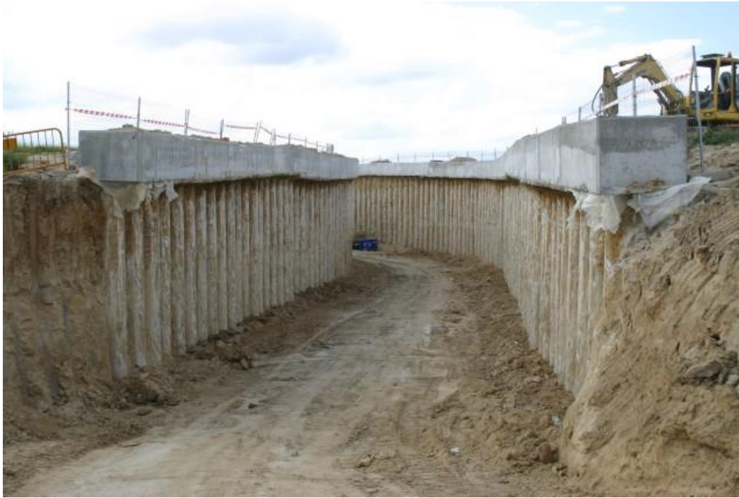
Figura 33. Construcción de falso túnel entre pantallas.
