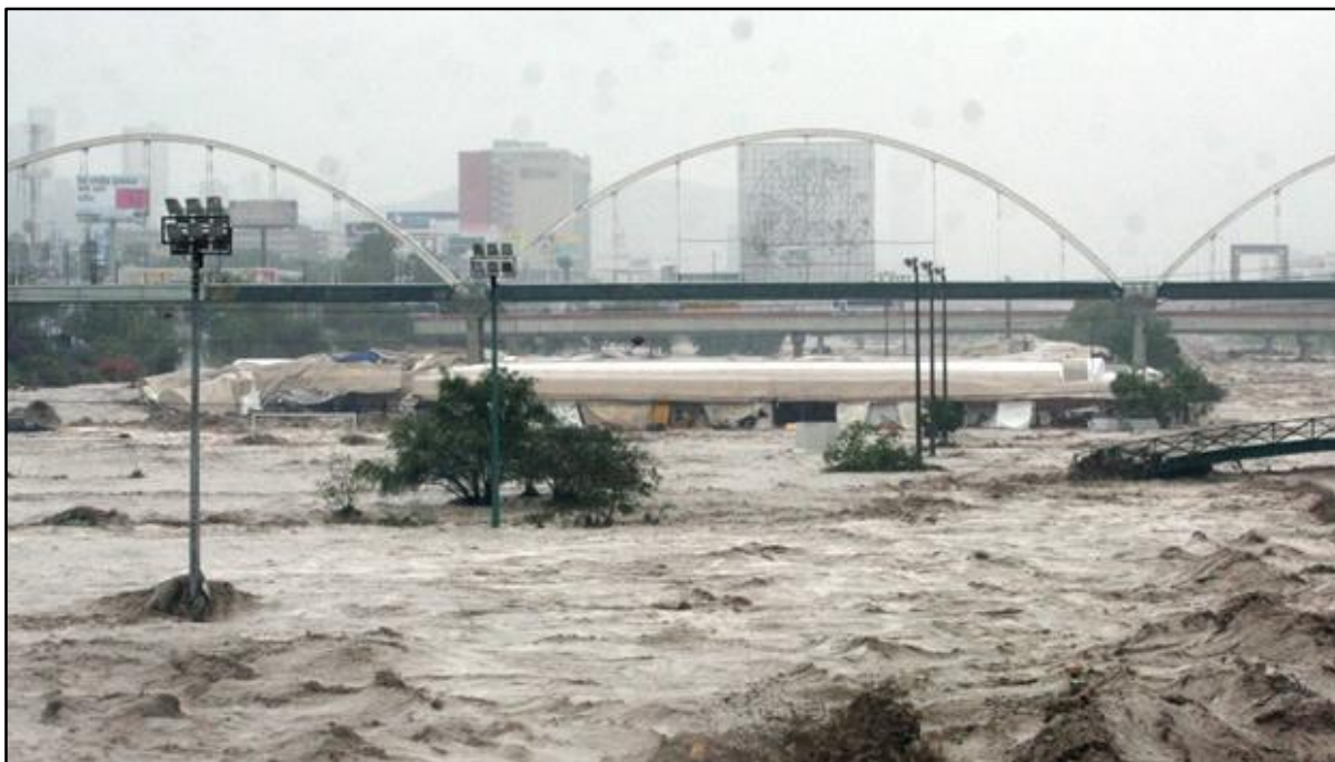
Ilustración 4.8 Puente "San Luisito" 2010 - Huracán Alex
