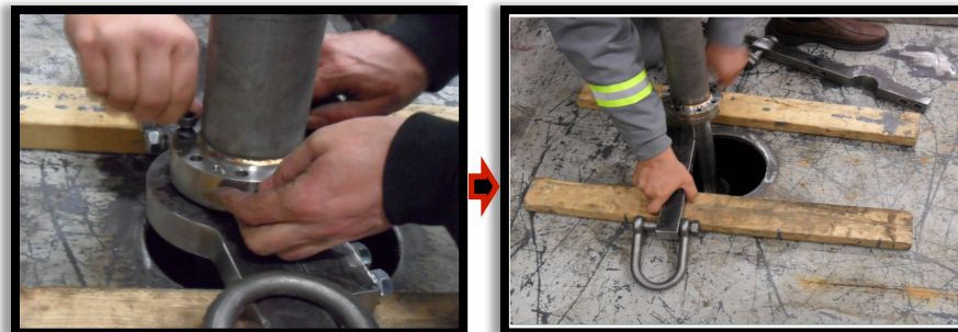
Fig. 43 Acople de motor y bomba en el pozo y retiro de eslingas.
