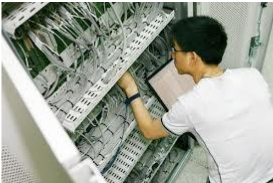
Figura 1.3.3 Mantenimiento de cableado estructurado
