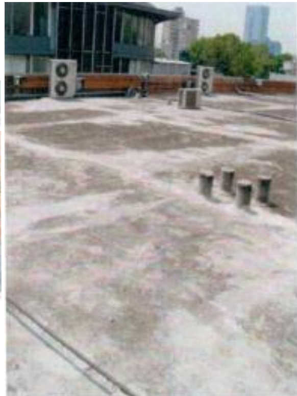
Figura 6.1.8.35 Azotea de la Universidad
