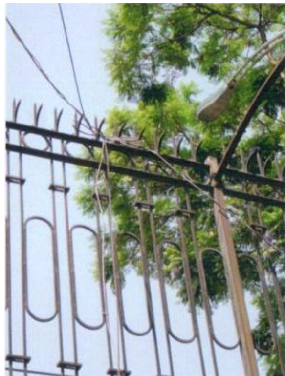
Figuras 6.1.8.32 y 6.1.8.33 Switch 3com localizado en el interior de oficina en Planta Piloto y cableado localizado sobre una de las rejas de la Universidad
