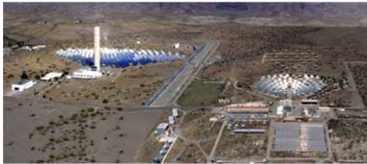
Ilustración 26 Campo de heliostatos en la plataforma solar de Almería (Pillatowsky, 2009).
