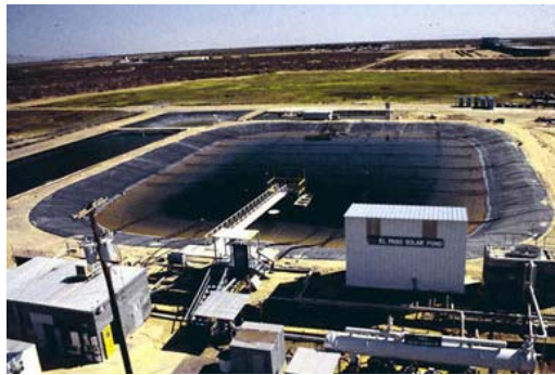
Ilustración 34. Estanque solar para desalación de agua (University of Nevada Reno).
