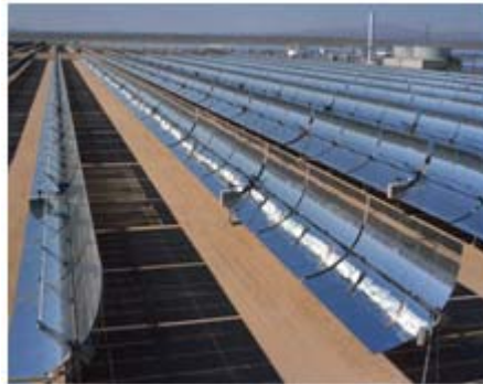
Ilustración 23. Concentrador de canal parabólico. El fluido fluye a lo largo de un tubo, y su trayectoria se localiza en la línea de focos de todas las parábolas que forman el canal (Pillatowsky, 2009).
