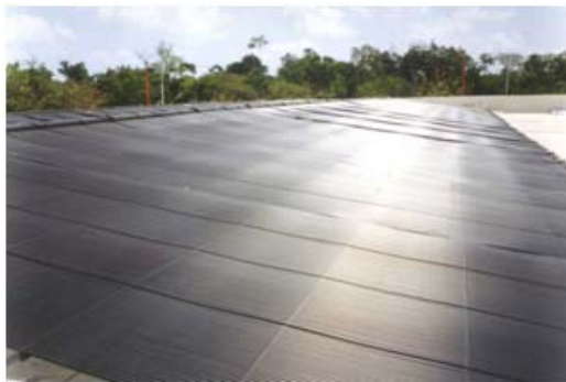
Ilustración 20. Concentrador plano de polipropileno para calentamiento de alberca (Pillatowsky, 2009).
