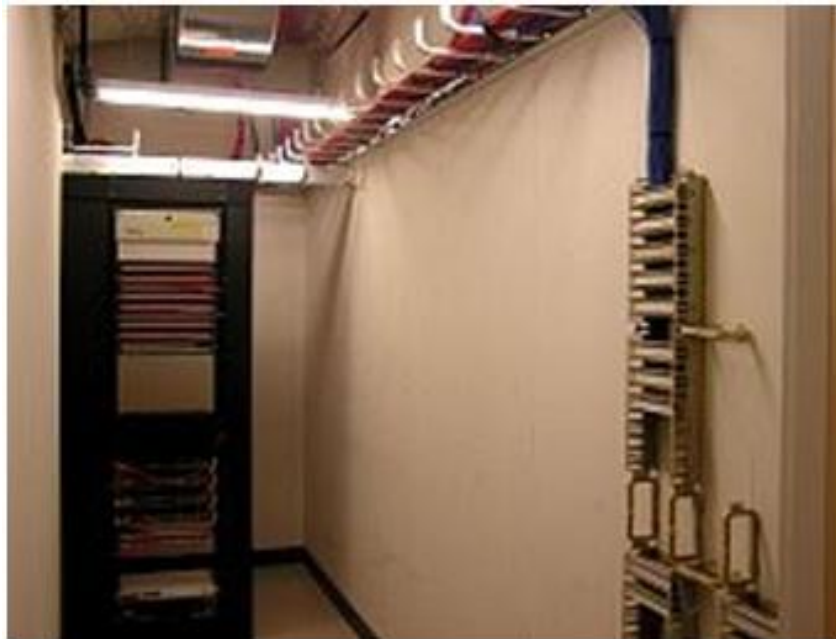
Fig. 3.1.1. Ejemplo de Cuarto de IDF
