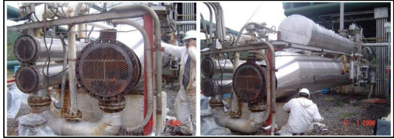
Figura 1. 29 Mantenimiento de intercambiadores de calor de central de generación binaria, los Azufres, Michoacán (IMPULSA IV, 2008)
