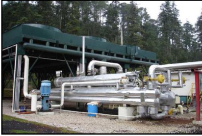
Figura 1. 28 Planta de ciclo binario Los Azufres, Mich. (IMPULSA IV, 2008).
