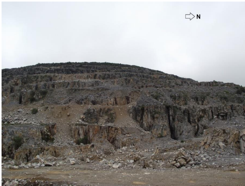
Figura V- 1 Área norte del área 2. La imagen muestra las condiciones en que se encuentra el área, los niveles muestran la acumulación de material estéril que obstruye la continuidad de los mismos en la mayoría de los casos, además de las diferentes alturas de los mismos, así como guatos que no están rellenos y que pueden generar accidentes.
