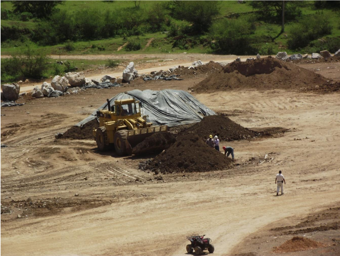
Figura V- 10 Patio de mineral.
