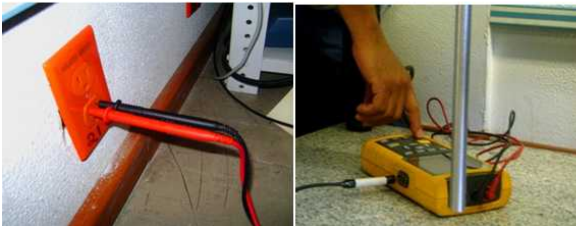
Figura 53. Equipo Fluke 43 Analizador Eléctrico Avanzado conectado al tomacorriente del laboratorio
