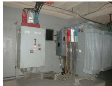
Figura 3.1 - Transformadores.
