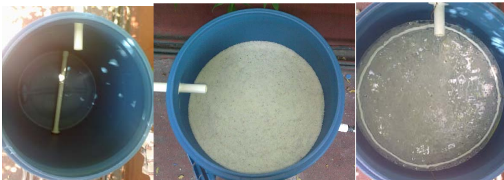
Figura 73. Construcción del filtro de arena.
