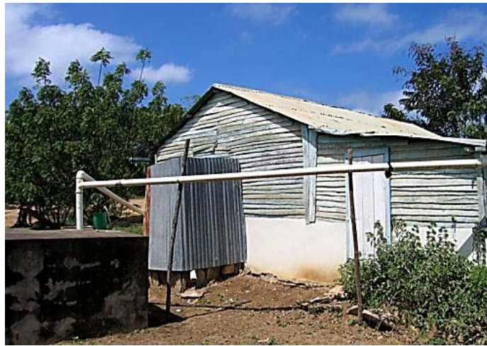
Figura 16. Captación de agua de lluvia a nivel familiar en República Dominicana.
