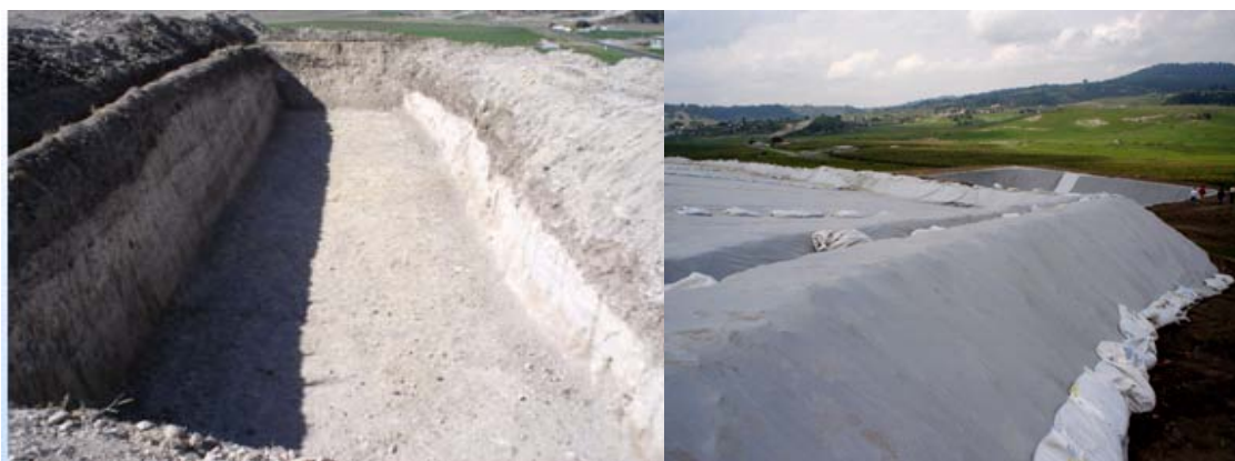
Figura 17. Cisterna revestida con geomembrana de PVC en la zona Mazahua. Fuente: CIDECALLI – CP
