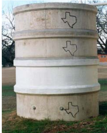
Figura 28. Tanque fabricado con anillos de concreto apilados.
