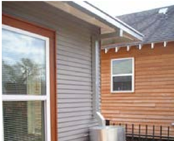
Figura 12. Sistema de captación de agua de lluvia básico. Dallas, Texas. Fuente: Jan Lewinski.
