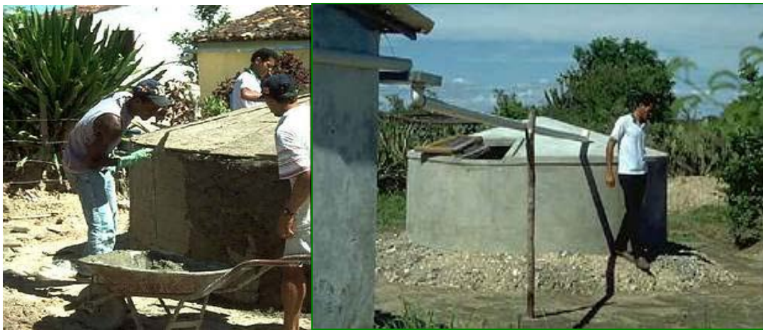
Figura 13. Cisternas de ferrocemento prefabricadas en Brasil. Fuente: foroantiguo.infojardin.com/showthread.php?t=182174
