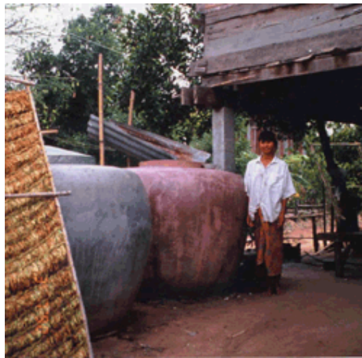
Figura 10. Sistema de captación y almacenamiento del agua de lluvia en Tailandia.
