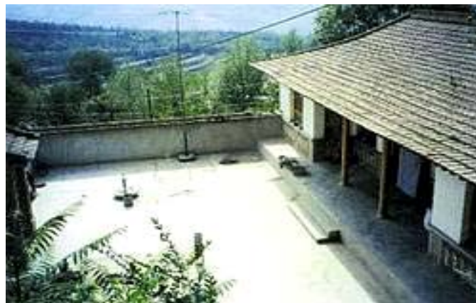
Figura 7. El agua es captada en el techo, se almacena bajo el piso y se extrae mediante una bomba de mano. Fuente: www.unep.or.jp
