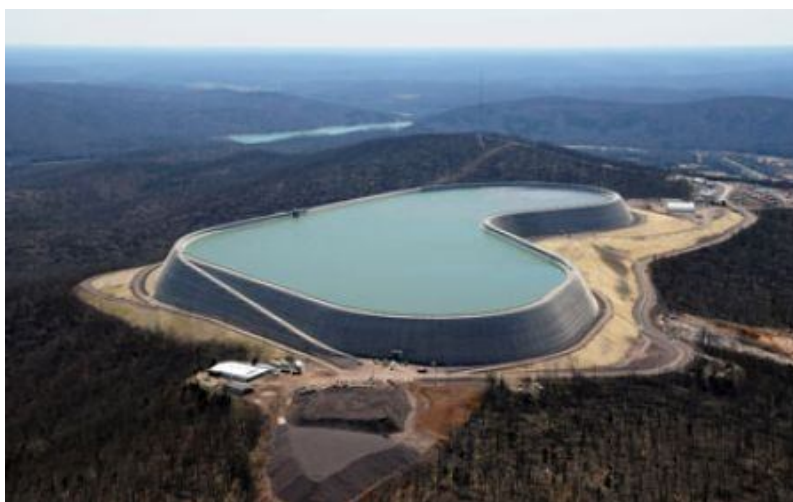
Figura 3.3. Reconstrucción de la planta hidroeléctrica Taum Sauk.
