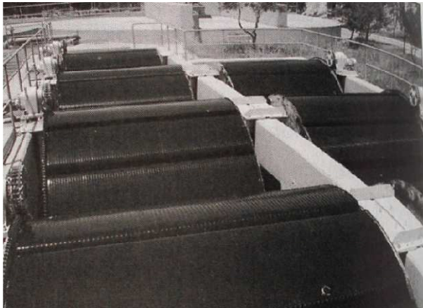
Figura 3-1c. Foto de biodiscos con un flujo perpendicular al eje
